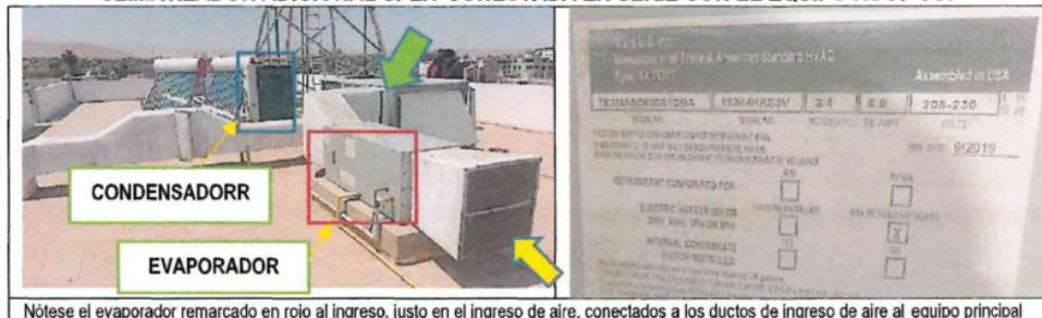
Nótese el evaporador remarcado en rojo al ingreso, justo en el ingreso de aire, conectados a los ductos de ingreso de aire al equipo principal
