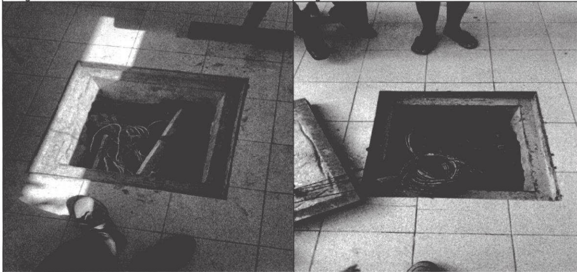
Fotografía n.º 3: Buzones eléctricos con presencia de agua acumulada.
