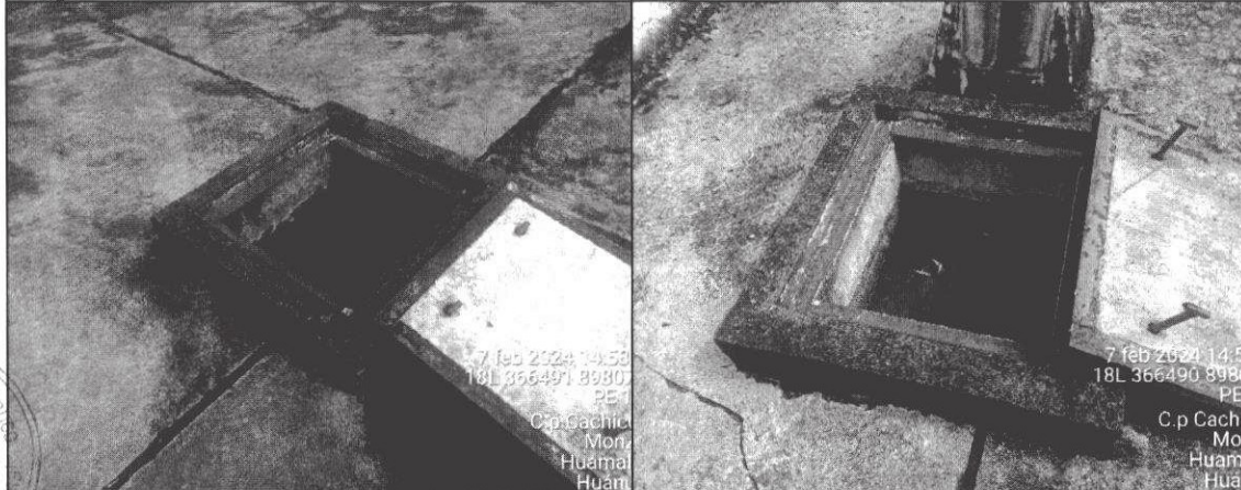
Fotografía n.º 3: Buzones eléctricos con presencia de agua acumulada.
