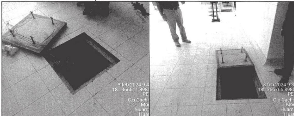
Fotografía n.º 1: Buzones eléctricos con presencia de agua acumulada.
