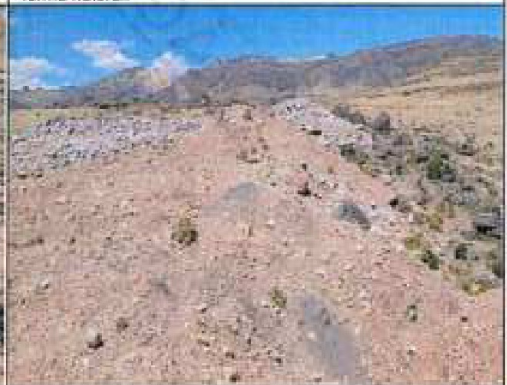
Imagen fotográfica n.º8: DME-3 contemplado en el expediente técnico de la Obra, ubicada en la progresiva Km 15+ 900 (a lado izquierdo de la carretera), en las coordenadas UTM N: 8548790,529; E: 461442,642, se observa que no guarde armonía con la morfología circundante; asimismo, se observa montículos de tierra, se advierte la no revegetación del terraplén y ladera del DME.
