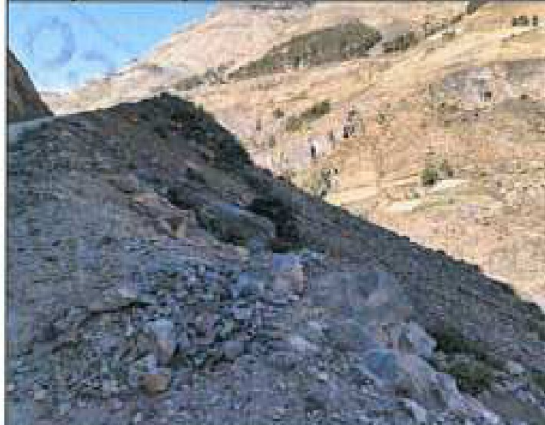
Imagen fotográfica n.º 19: Tramo Km 7+800 a KM 8+000: Material excedente compuesto principalmente por tierra y piedras medianas, presenta las mismas características del terreno de corte, genera un riesgo de inestabilidad.
