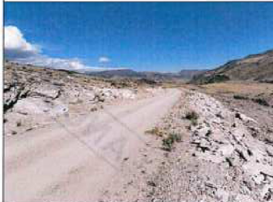
Imagen fotográfica n.º 25: Tramo KM 25+900 a KM 26+200, se identificó piedras de color blanco eliminados al borde de la vía que presenta las mismas características del terreno de corte de la conformación de la plataforma de rodadura.
