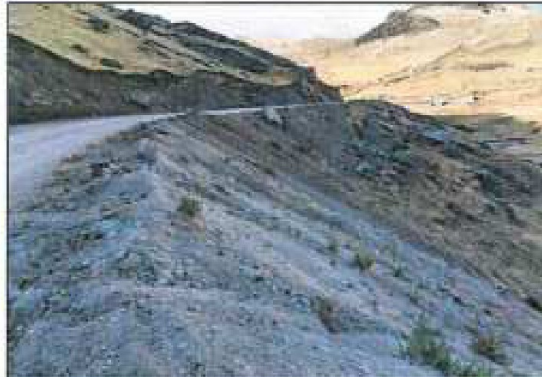
Imagen fotográfica n.º 23: Tramo Km 21+570 a Km 21+630: Se identificó material excedente eliminado al borde de la vía, encontrándose por encima del nivel de la plataforma.
