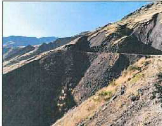
Imagen fotográfica n.º 17: Tramo KM 6+620 a KM 6+710: Material excedente compuesto principalmente por tierra y piedras medianas, presenta las mismas características del terreno de corte, genera un riesgo de inestabilidad.
