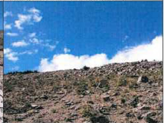
Imagen fotográfica n.º 26: Tramo KM 27+290 a KM 27+310, material excedente compuesto principalmente por tierra y piedras medianas, presenta las mismas características del terreno de corte, genera un riesgo de inestabilidad.
