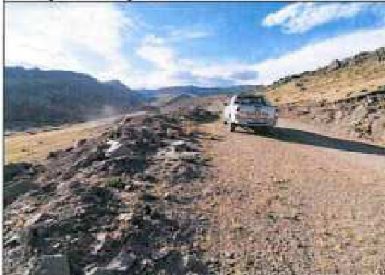
Imagen fotográfica n.º 21: Tramo Km 17+940 a Km 17+970: Material excedente compuesto principalmente por tierra y piedras medianas, presenta las mismas características del terreno de corte, genera un riesgo de inestabilidad.
