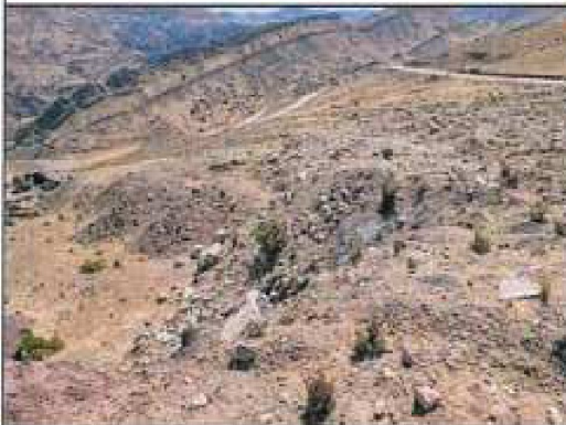
Imagen fotográfica n.º7: DME-3 contemplado en el expediente técnico de la Obra, ubicada en la progresiva Km 15+ 900 (a lado izquierdo de la carretera), en las coordenadas UTM N: 8548790,529; E: 461442,642, se observa que no guarde armonía con la morfología circundante; asimismo, se observa montículos de tierra, se advierte la no revegetación del terraplén y ladera del DME.
