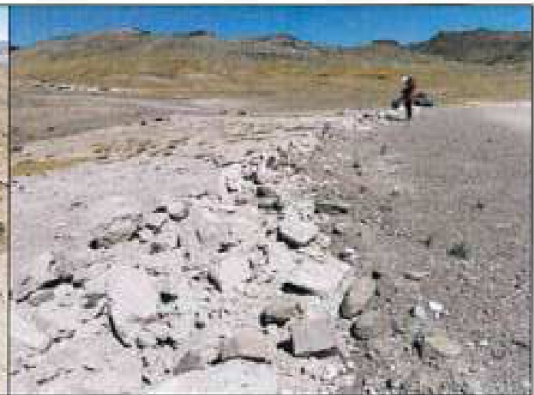
Imagen fotográfica n.º 30: Tramo Km 34+415 a Km 35+735: Material excedente compuesto principalmente por tierra y piedras medianas al borde la vía, presenta las mismas características del terreno de corte.
