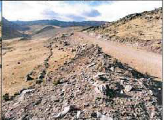
Imagen fotográfica n.º 22: Tramo Km 20+600, Material excedente compuesto principalmente por tierra y piedras medianas, presenta las mismas características del terreno de corte.
