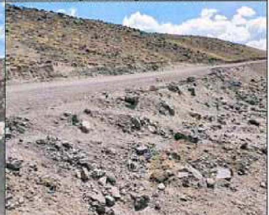
Imagen fotográfica n.º 28: Tramo Km 34+700 a Km 34+750: Material excedente compuesto principalmente por tierra y piedras medianas, presenta las mismas características del terreno de corte.
