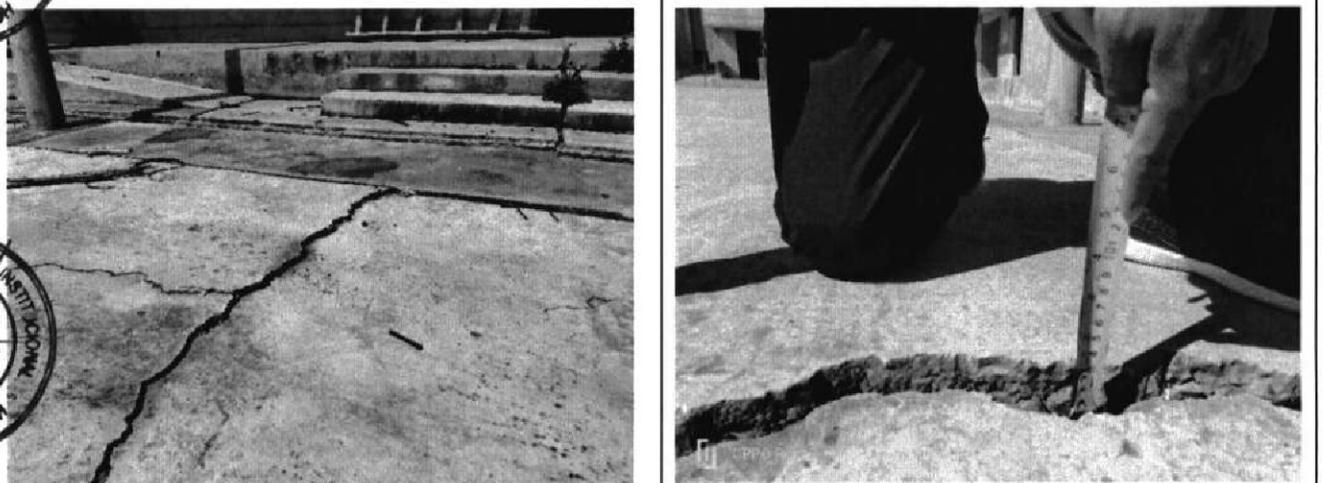
Presencia de fallas transversales de espesor de 3 a 10 mm., con asentamiento diferencial de 2.5 cm., por lo que requiere ser reemplazada
