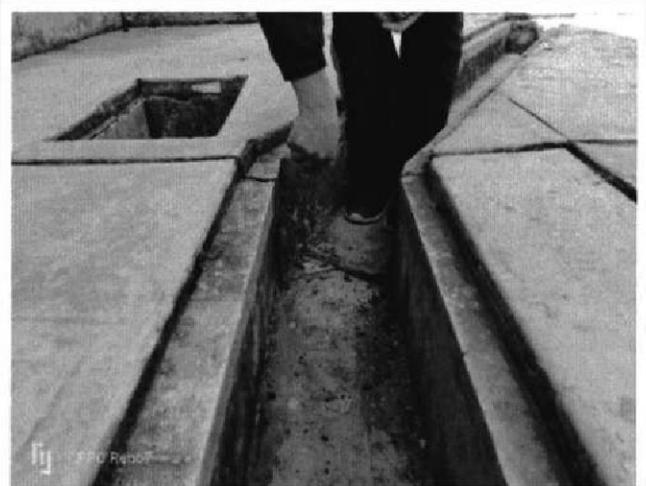
Imágenes del 160 al 163: En el canal de drenaje pluvial se observó desprendimiento del tarrajeo que requiere ser reemplazado, asimismo, se observó grietas en la base y paredes del canal.
