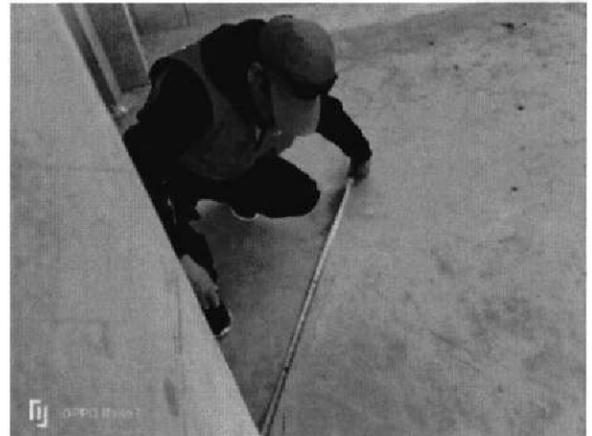
Fisuras de espesores que varía de 0.5 mm a 1 mm, en el piso pulido del aula 3.
