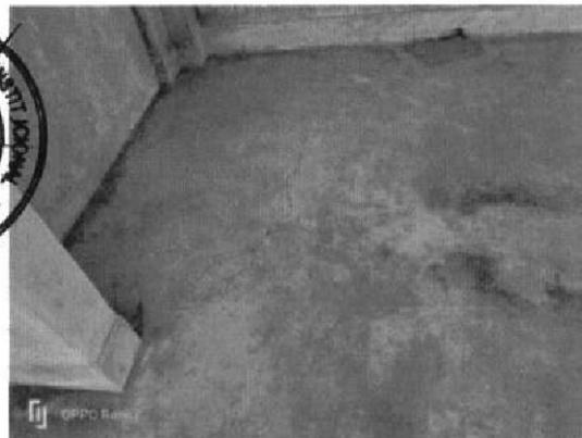
Fisuras de espesores que varía de 0.5 mm a 1 mm, en el piso pulido del aula 6
