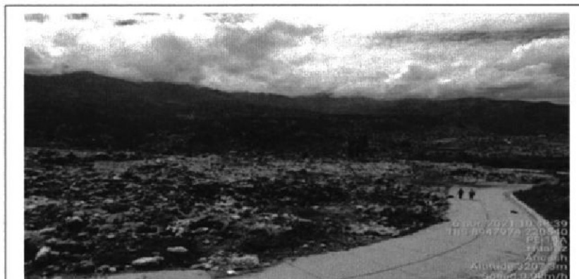
De la fotografía TimePhoto_20210406_104839, de la supervisión de abril 2021 (primera acción de supervisión), se observa la ausencia de chimeneas para la evacuación de gases generados a partir de la disposición de los residuos sólidos.
