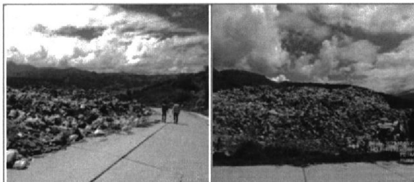
De la fotografía TimePhoto_20210406_104359, TimePhoto_20210406_105547 de la supervisión de abril 2021, del cual se observa que los residuos sólidos ya se encontraban siendo dispuestos sin la compactación y cobertura diaria con material de la zona
