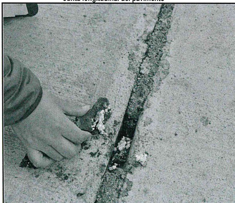
Imagen n.º 44 Junta longitudinal del pavimento
