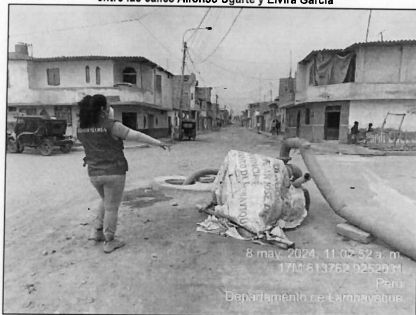
Imagen n.° 31 Buzón abierto con manga de 6" conectada a motobomba de 6" entre las calles Alfonso Ugarte y Elvira García
