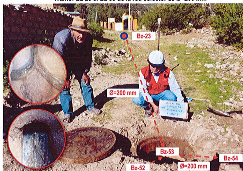
Imagen n.º 18 Tramo: Bz 23 al Bz 53 de la red colector de Ø=200 mm
