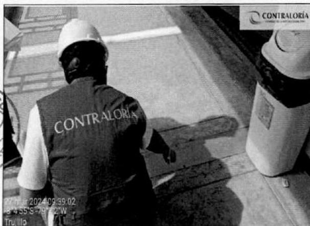
Tapajunta metálica en piso en el 3er nivel, entre módulo 1 y escalera 1, con un espaciado de anclaje mayor a 0.25m y colocados en ambos módulos
