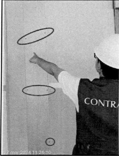
Tapajunta metálica en columna nivel, entre módulo 2 y escalera 2, con tornillos de fijación en ambos módulos
