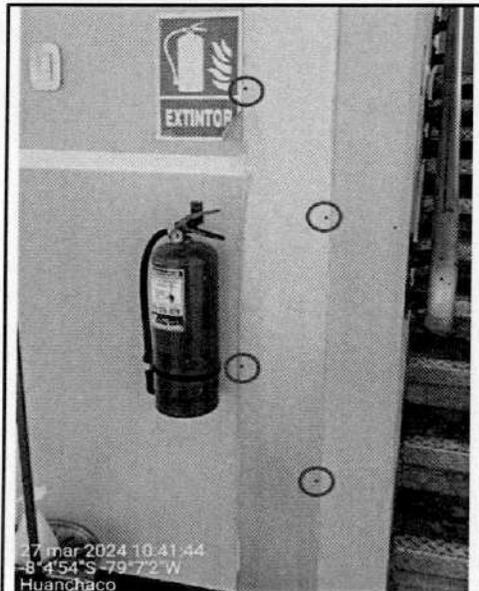
Tapajunta metálica en columna en el 3er nivel, entre módulo 3 y 4, con un espaciamento entre pernos de anclaje mayor a 0.25 m
