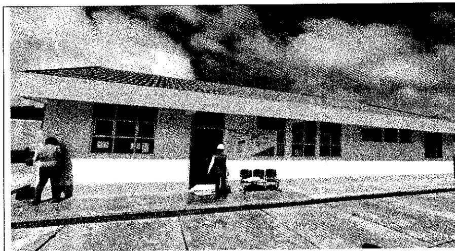
Fotografía n.º 3 Se realizó la medida del largo total del módulo, obteniéndose 19.60 m, lo que es inconsistente con los 21.31 que indica el Plano LAE-01 Distribución Arquitectura – Módulo I
