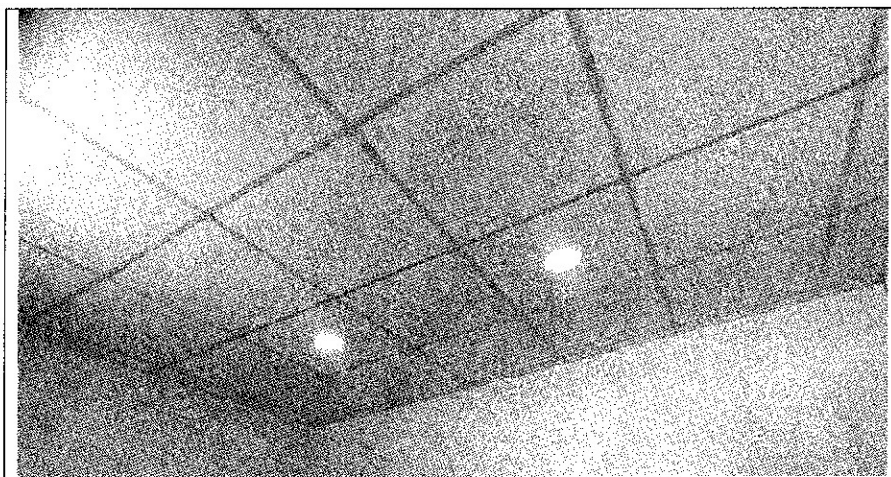
Fotografía n.º 45 Ambiente del almacén de alimentos donde se instaló luminarias led circular adosable de 18 w.
