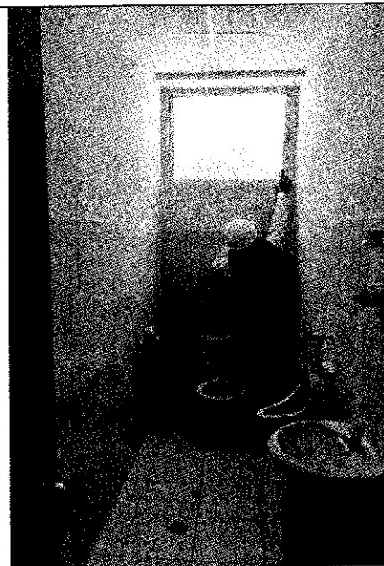
Fotografía n.º 2 Se obtuvo las medidas de las puertas y ventanas con la finalidad de descontar al área de pintado de los muros.
