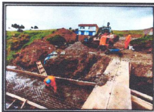
FOTO N° 20: Producción y vaciado de concreto para la losa fondo de la Alcantarilla en la Calle Augusto B. Leguia.
