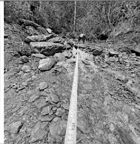
Fotografía n.º 7: En la progresiva 0+028 río arriba medido desde el puente, se observa que el cauce del río se encuentra sin trabajos de encausamiento y descolmatación, puesto que no forma una sección de canalización de escurrimiento continuo.
