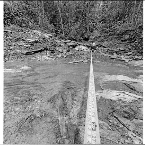
Fotografía n.º 8: Se observa que en la progresiva 0+021 río arriba medido desde el puente, se observa que el cauce del río se encuentra sin trabajos de encausamiento y descolmatación, puesto que no forma una sección de canalización de escurrimiento continuo.
