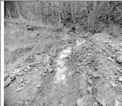
Fotografía n.º 17: En la progresiva 0+015 río arriba medido desde el puente, se observa que el cauce del río se encuentra sin trabajos de encausamiento y descolmatación, puesto que no forma una sección de canalización con las medidas: ancho de 3.20 m y alto de 2.50 m
