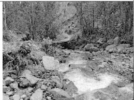
Fotografía n.º 20: Se observa que en la progresiva 0+010 río abajo medido desde el puente, se observa que el cauce del río se encuentra sin trabajos de encausamiento y descolmatación, puesto que no forma una sección de canalización.
