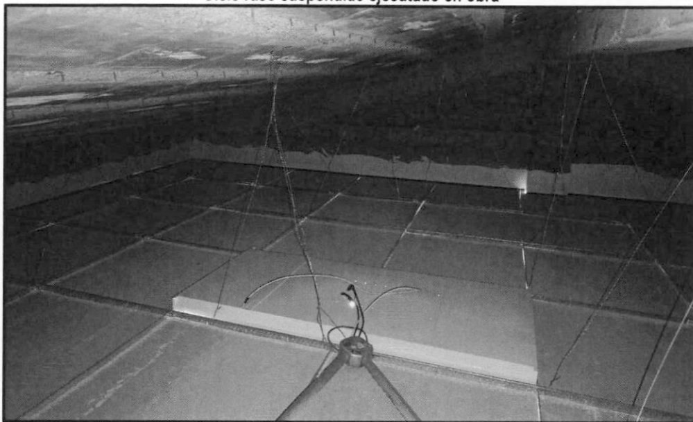
Imagen n.º 50 Cielo raso suspendido ejecutado en obra
