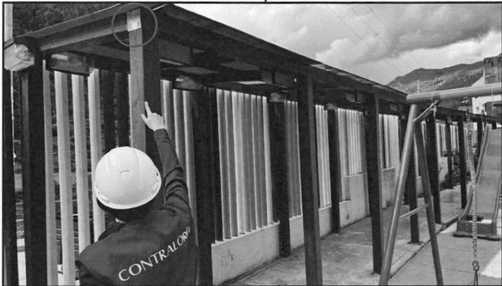
Imagen n.º 82 Circulación techada ejecutado en obra
