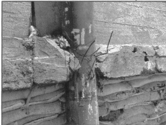
Imagen n.º 43 Cinta de confinamiento sin amarre con el pilote
