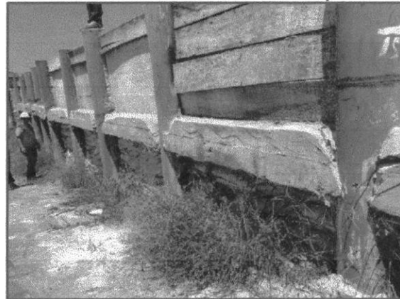
Imagen n.º 44 Cinta de confinamiento sin amarre con el pilote
