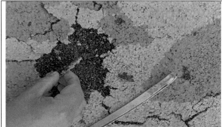
En la imagen solo se aprecia una capa de caucho, la estructura de la pista atlética tipo sándwich no presenta capas, y esta pintada.
