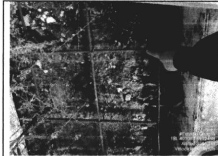
Fotografía n.º 7: Se visualiza, acero de refuerzo transversal intercalo entre acero de \varnothing 1/2" y \varnothing 3/8" .
