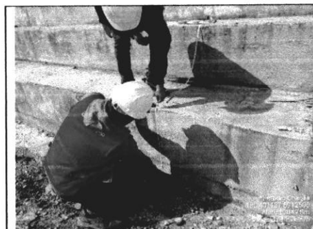
Fotografía n.º 11: Se visualiza, la medición del contrapaso en las gradas construidas de la tribuna sur.
