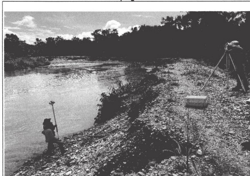
Panel Fotográfico n.º 1 Área intervenida desde la progresiva 0+610 al 0+835.28
