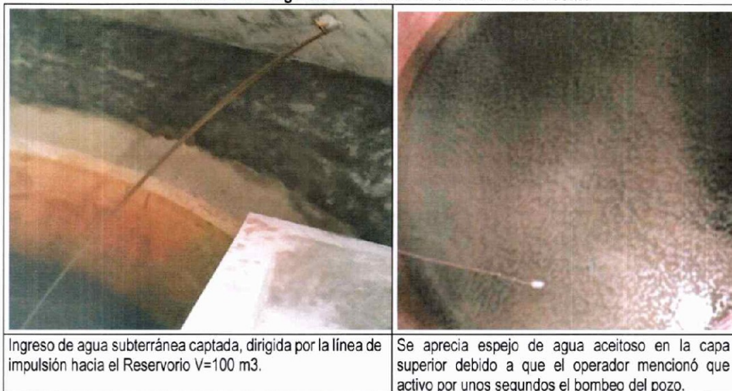
Galería de Imágenes n.º 5 - Interior del reservorio 100m 3
