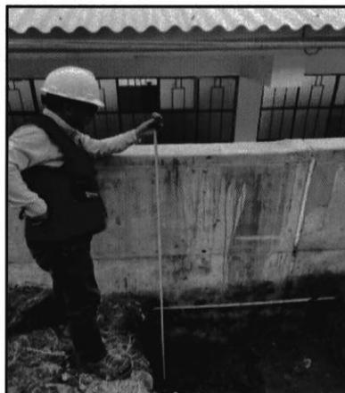
No se advierte material de filtro de piedra de ½" a ¾" a una excavación de 2.10 m del nivel del borde del muro.
