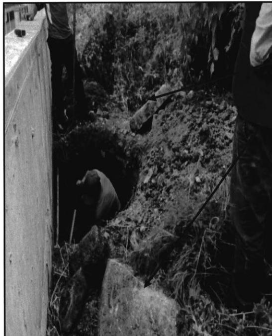
Rocas de más de 50 cm encontradas en la excavación, con lo que se demuestra que no se ha ejecutado la partida de relleno con material propio seleccionado
