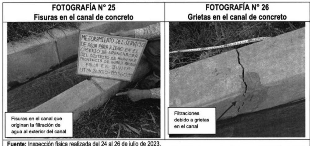
Los hechos expuestos, ocasionan la disminución del caudal de transporte de agua para riego y la imposibilidad de transportar el caudal máximo de agua para el cual fue diseñado la Obra de tal manera que se cubra la demanda de la población beneficiaria; al respecto, se muestran algunas fotografías que evidencian el deterioro originado y el cuadro con la ubicación de las fallas en el canal de concreto:
