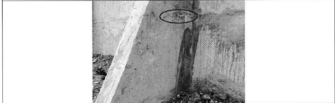
Se identifican 5 zonas de filtración con evidencia de eflorescencia en el contrafuerte C-2 comprendido entre las progresivas Km 0+036.37 hasta Km 0+036.68.
