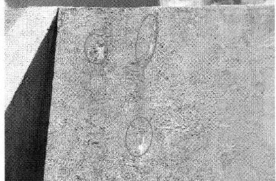
Se identifica un promedio de trece (13) zonas de filtración con evidencia de eflorescencia en el paño P-18 comprendido entre las progresivas Km 0+090.62 hasta Km 0+094.70.
