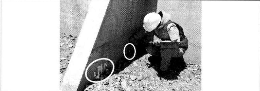
Se identifican 5 zonas de filtración con evidencia de eflorescencia en el contrafuerte C-12. Se observa la cara lateral derecha.
