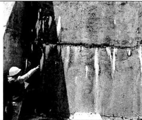
Se muestran los trabajos de cobertura con mezcla de mortero de cemento en la cara seca de la pantalla de la represa y contrafuerte, así como áreas de unión de paño de concreto vaciado en diferentes etapas cubiertos por la mezcla de mortero de cemento.
