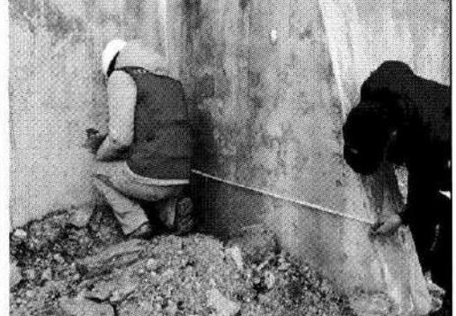
Contrafuerte C-2 de la represa. Se registra una longitud inclinada de 4.82 m, ancho en la parte alta y baja de 0.32 m y 0.31, respectivamente y una profundidad a la pantalla de 1.60 m.
