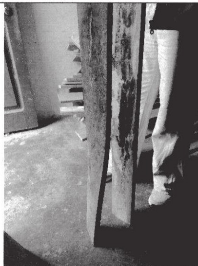
Se observa diversas tablas de la parrilla pandeadas (torcido) y con presencia de humedad.
