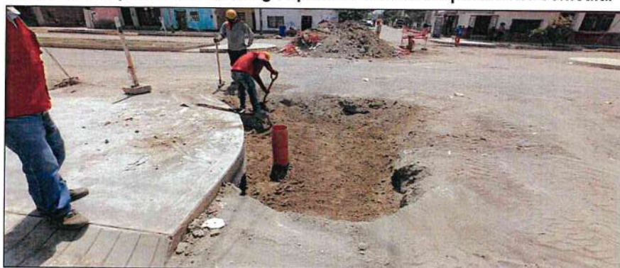
Imagen n.º 21 Zona de empalme de red de agua potable en área de pavimento vehicular
