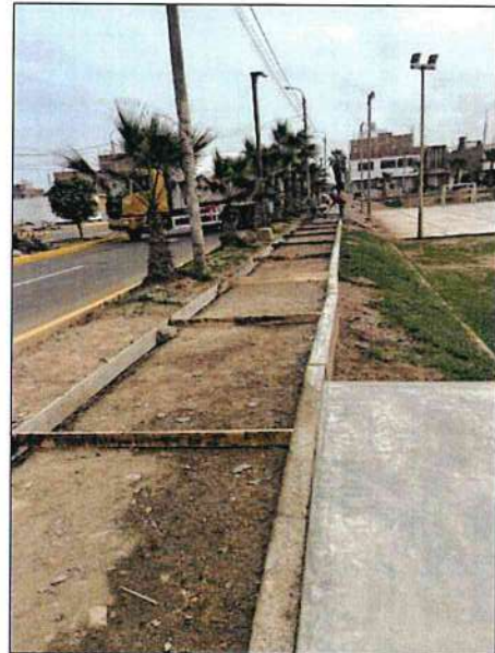
Imagen n.º 33 Encofrado de veredas
