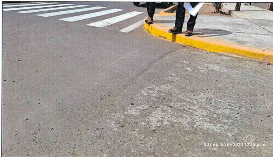
Fuente: Acta de inspección física de obra de 15 de junio de 2023.
