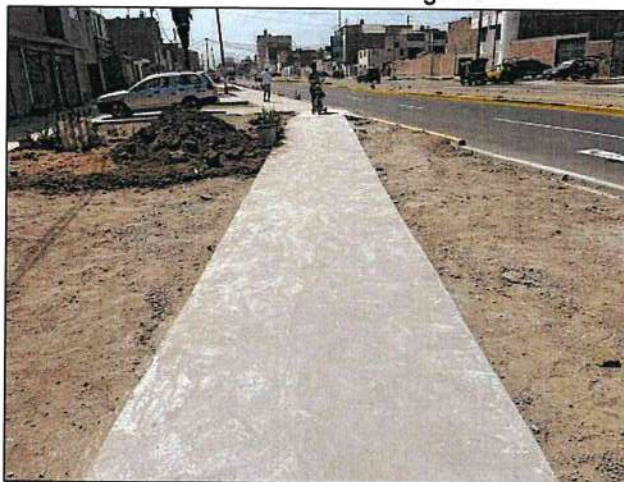
Imagen n.º 2 Techado de canal de regadío
