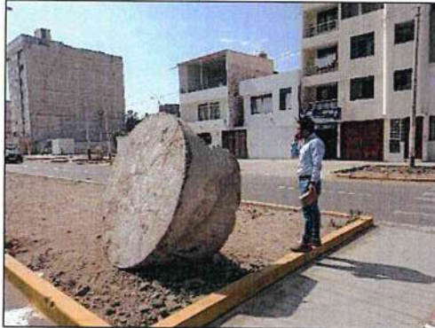
Imagen n.º 46 Falta limpieza de obra
