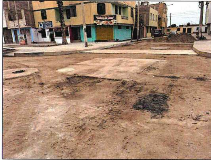
Fuente: Acta de inspección física de obra de 2 de junio de 2023.
