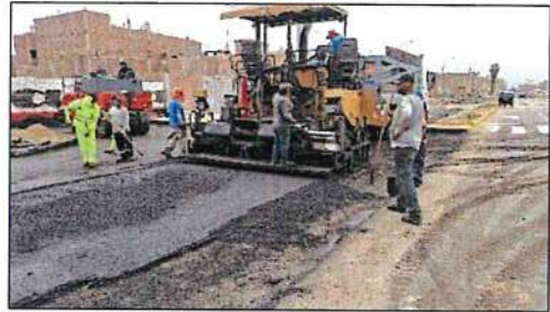
Imagen n.º 31 Colocación de carpeta asfáltica
