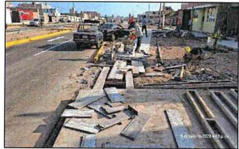
Imagen n.º 29 Encofrado de techo de canal
