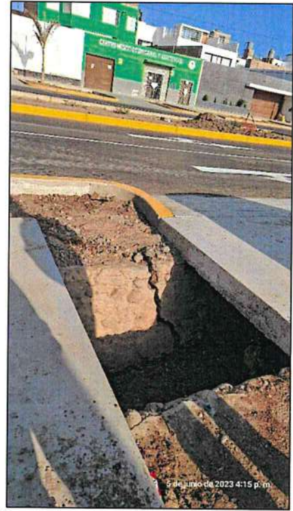
Fuente: Acta de inspección física de obra de 5 de junio de 2023.
