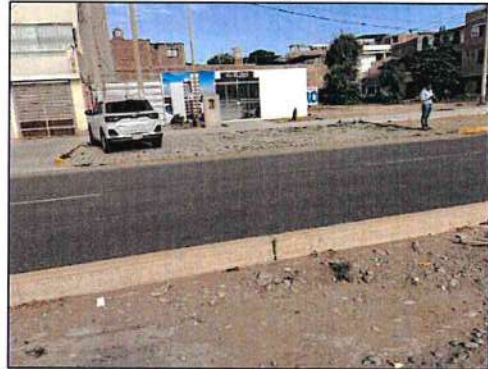
Imagen n.º 41 Sardinel no ejecutado
