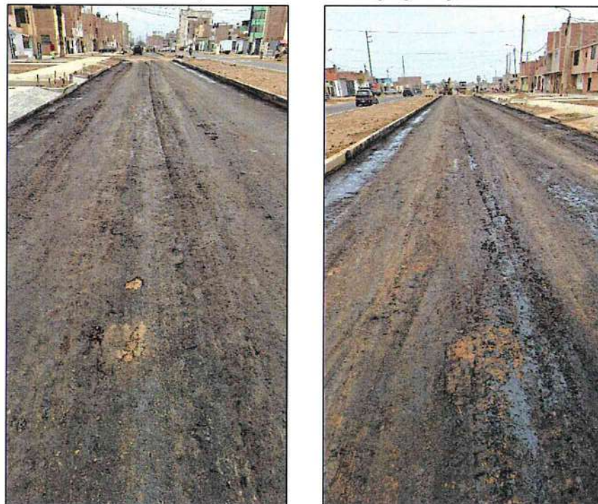
Fuente: Acta de inspección física de obra de 2 de junio de 2023.
