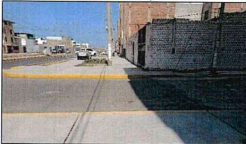
Imagen n.º 50 Señalización no ejecutada
