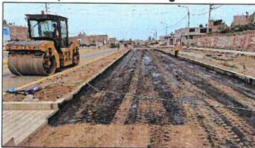
Imagen n.º 30 Imprimación de base granular
