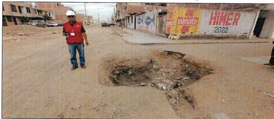
Imagen n.º 18 Zona de empalme de red de agua potable en área de pavimento vehicular
