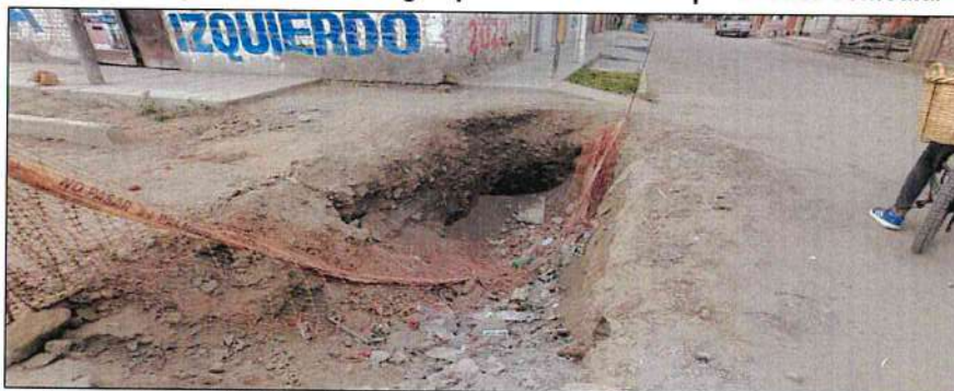
Imagen n.º 20 Zona de empalme de red de agua potable en área de pavimento vehicular
