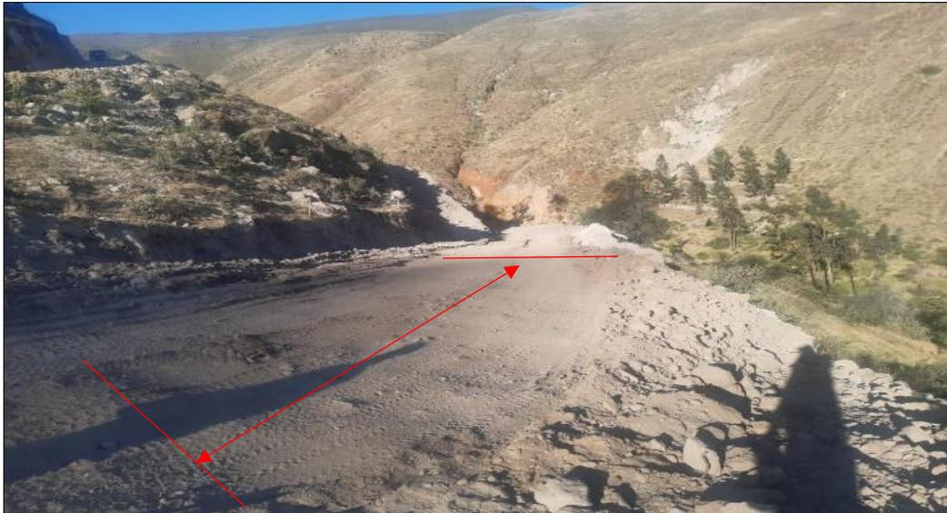
**Comentario:** Se aprecia el relleno ejecutado por el contratista en el tramo 39+680 al 39+720, inobservando con las especificaciones técnicas de la partida relleno con material propio seleccionado contenida en el expediente técnico
