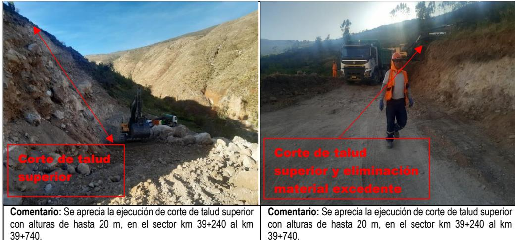
**Comentario:** Se aprecia la ejecución de corte de talud superior con alturas de hasta 20 m, en el sector km 39+240 al km 39+740.
