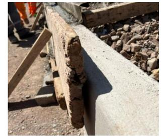
MADERA ASTILLADA USADA PARA ENCOFRADO DE SARDINEL
