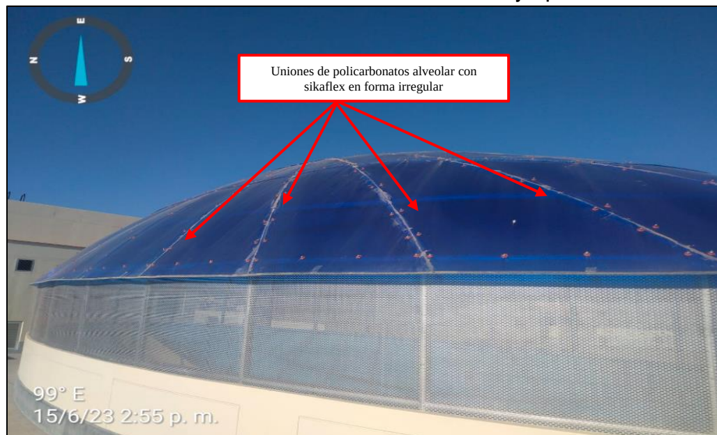
Imagen n.º 3 Deficiencias constructivas en las uniones de la claraboya tipo 1
