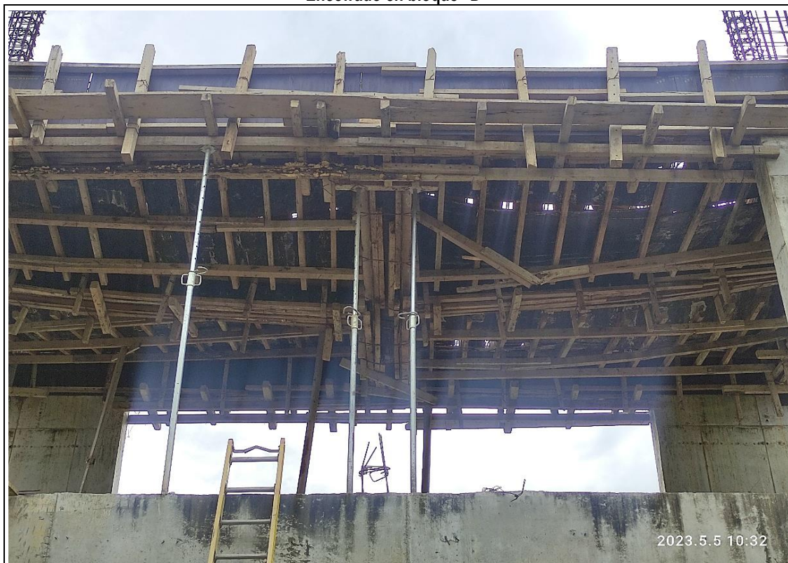
Imagen n.º 21 Encofrado en bloque “D”
