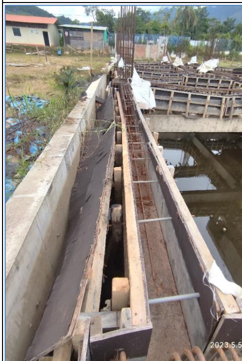
Descripción: Acero longitudinal extraído en viga A1/SA-V01 entre ejes A4 y A5, según plano E-09 de la especialidad de Estructuras Fecha: 05/05/2023
