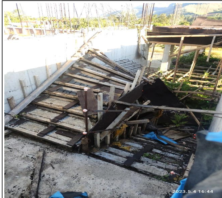
Imagen n.º 18 Encofrado en bloque “As2”
