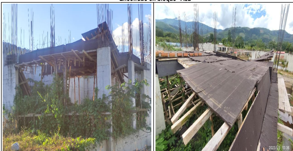
Imágenes n.ºs 16 y 17 Encofrado en bloque “As2”
