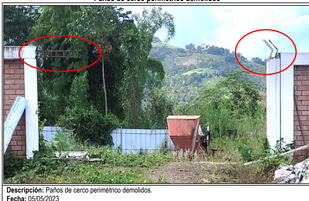
Imagen n.º 75 Paños de cerco perimétrico demolidos
