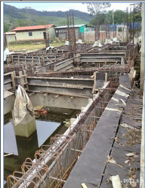
Descripción: Acero longitudinal extraído en viga A1/SA-V03 entre ejes A5 y A6, según plano E-09 de la especialidad de Estructuras Fecha: 05/05/2023
