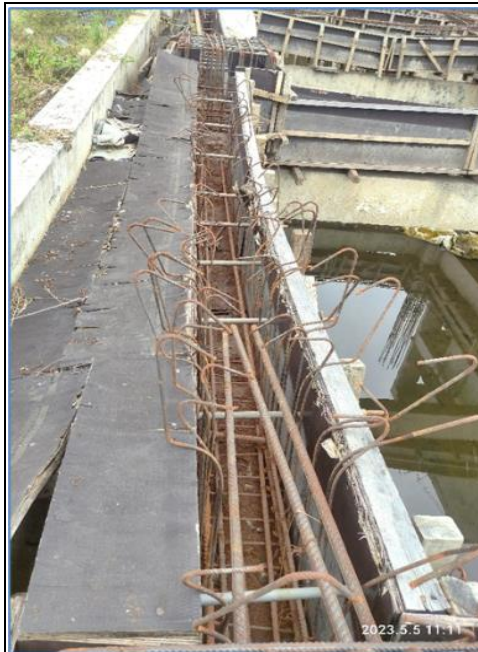
Descripción: Acero longitudinal extraído en viga A1/SA-V01 entre ejes A5 y A6, según plano E-09 de la especialidad de Estructuras Fecha: 05/05/2023
