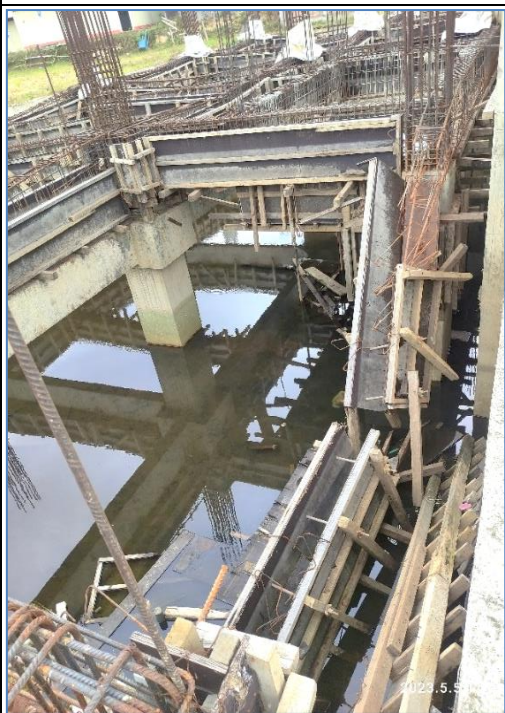
Descripción: Acero longitudinal extraído en viga A1/SA-V03 entre ejes A4 y A5, según plano E-09 de la especialidad de Estructuras Fecha: 05/05/2023
