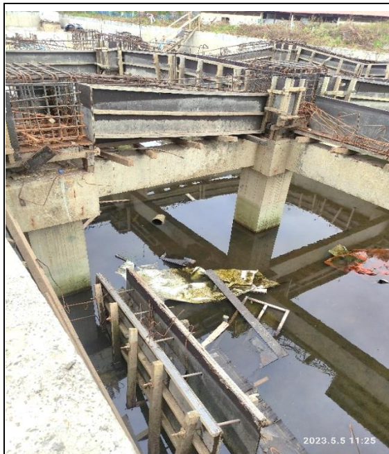
Imágenes n.ºs 19 y 20 Encofrado en bloque “A1”
