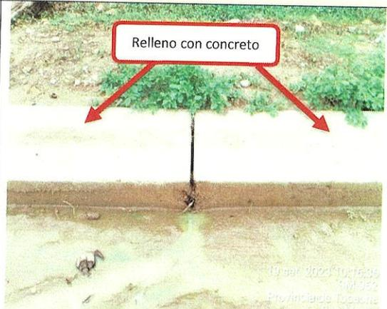
En la fotografía se muestra el relleno de concreto a una cuneta en la losa superior de la cuneta rectangular tapada.
