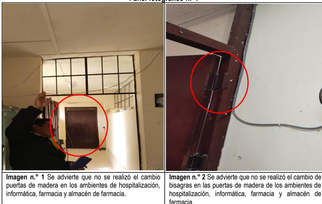
**Imagen n.° 1** Se advierte que no se realizó el cambio puertas de madera en los ambientes de hospitalización, informática, farmacia y almacén de farmacia.
