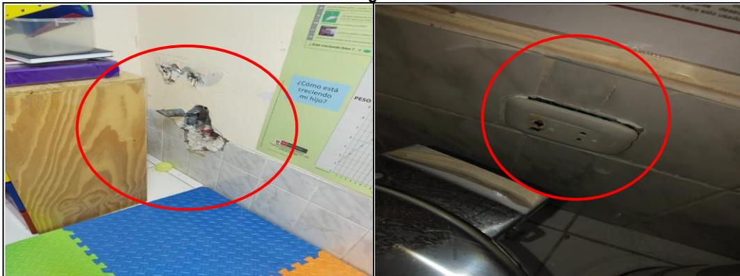
**Imagen n.º 13** Se evidenció que no se realizó la instalación de válvula de compuerta de bronce unión roscada 1/2" y grifo cuello de ganso de 1/2" en los ambientes de sala de parto, sala de emergencia y odontología
