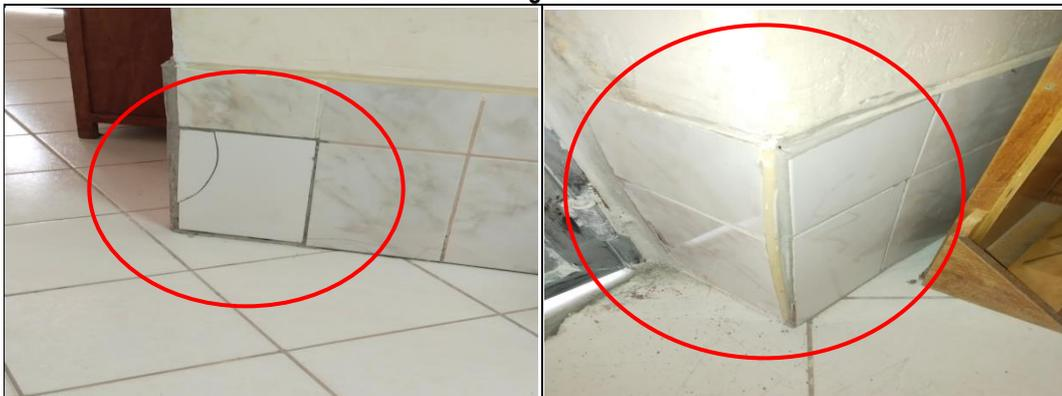
**Imágenes n.ºs 11 y 12** se observa que el enchapado de cerámica en los zócalos fue deficiente se colocaron cerámicas rotas y el acabado no cumple las especificaciones técnicas.
