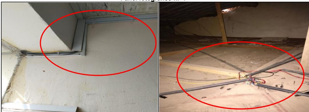
**Imagen n.º 7** de la inspección al centro de salud Julcamarca, solo se encontro una canaleta existente de 40 mm para el cableado del internet.
