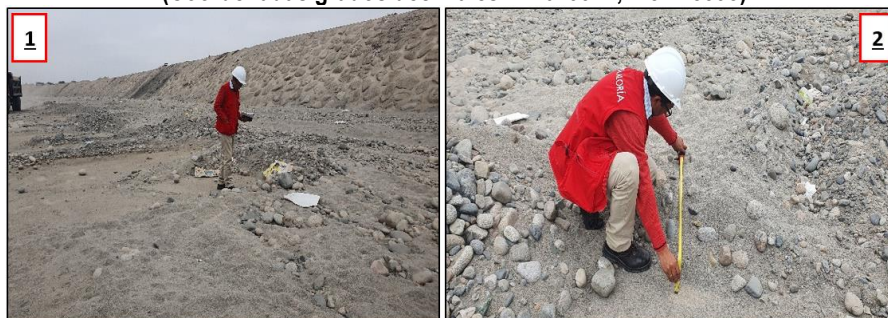
1. Piedras de canto rodado y arena sobre losas construidas en obra. 2. Medición de altura del material que cubre las losas, en este punto es de 0.12 m aproximadamente.
