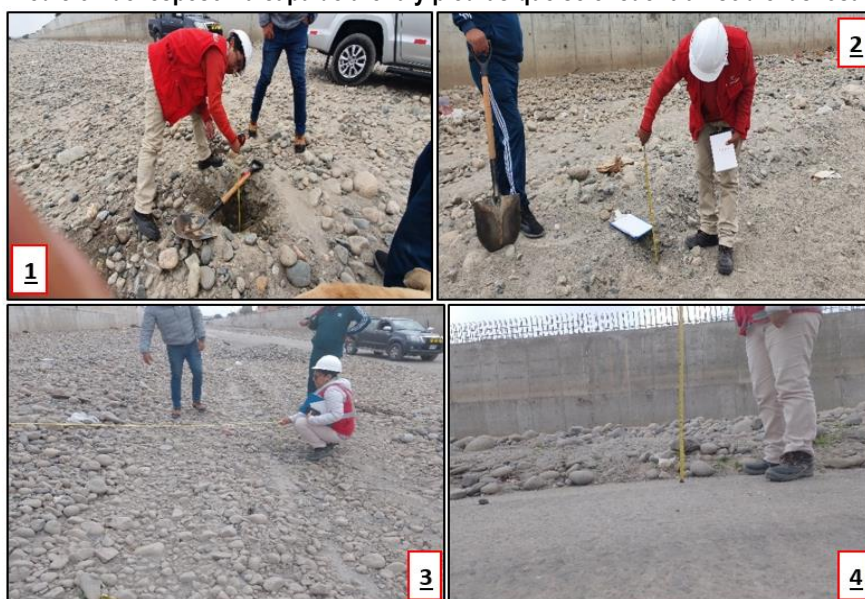
1. Espesor de material (piedras y arena) de 0.39 m sobre la losa. (Coordenadas grados decimales -14.051332, -75.728206). 2. Espesor de material de 0.20m. (Coordenadas grados decimales -14.053355, -75.727510) 3. Medida de espesor de capa de material de piedras sobre la losa de concreto de altura de 0.40m aprox. (Coordenadas grados decimales -14.055891, -75.726578) 4. Medida de espesor de capa de material de 0.40m aprox. (Coordenadas grados decimales -14.058007, -75.725731).
