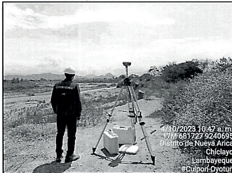
IMAGEN N°01: MONTAJE DE EQUIPO GNSS DIFERENCIAL TRIMBLE R8S
