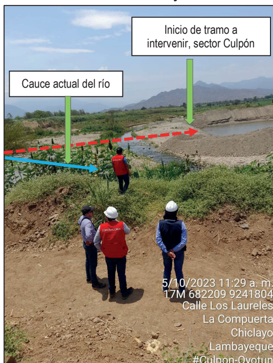
Imagen n.º15 Inicio de tramo intervenido y cauce actual.
