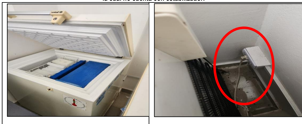
Imagen n.º 7 y 8: Congeladora eléctrica de almacenamiento de paquete fríos operativa la cual no cuenta con estabilizador.
