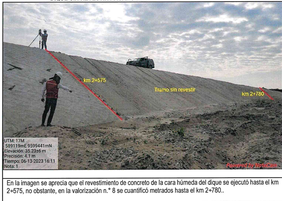
IMAGEN N.º 2 DIQUE SIN REVESTIR PAGADO EN LA VALORIZACIÓN N.º 8
