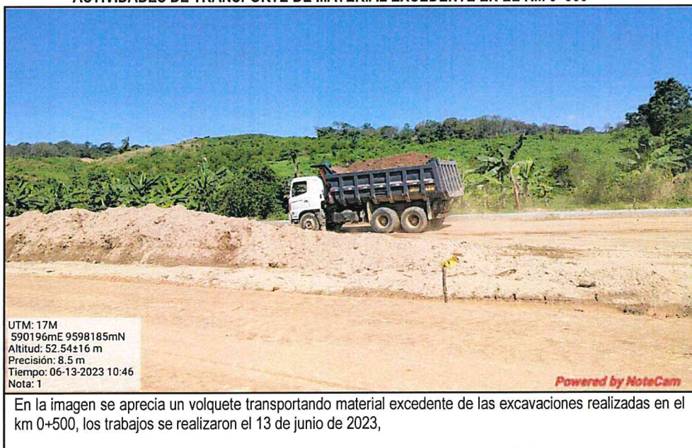
IMAGEN N.º 9 ACTIVIDADES DE TRANSPORTE DE MATERIAL EXCEDENTE EN EL KM 0+500
