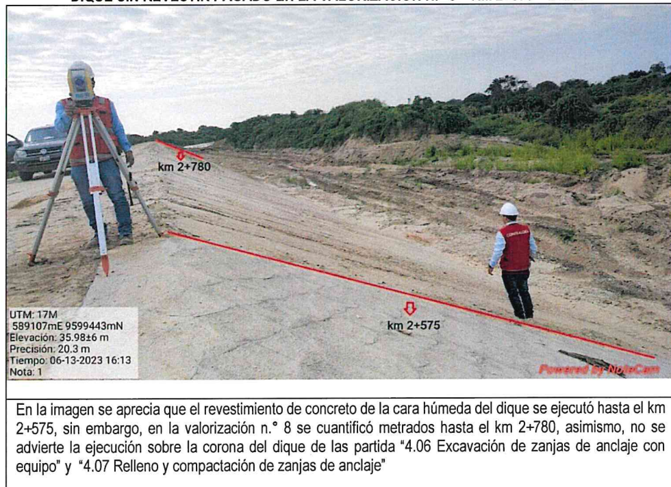
IMAGEN N.º 3 DIQUE SIN REVESTIR PAGADO EN LA VALORIZACIÓN N.º 8 – KM 2+575 – 2+780
