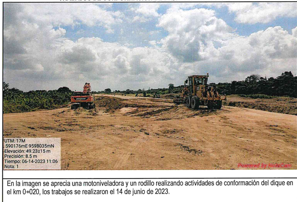
IMAGEN N.° 10 TRABAJOS DE CONFORMACIÓN DE DIQUE EN EL KM 0+020
