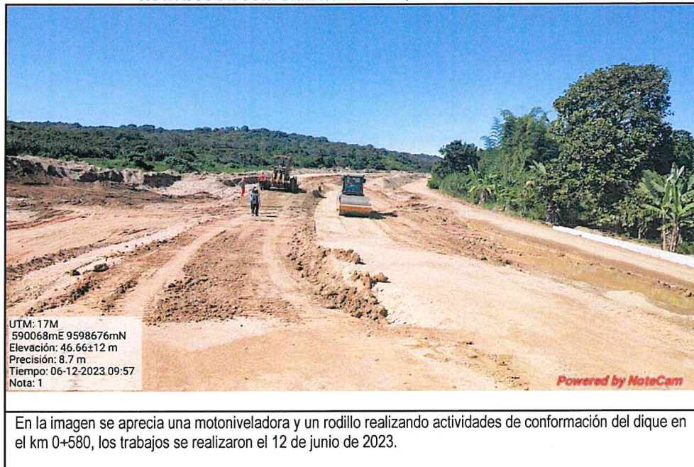
IMAGEN N.º 8 TRABAJOS DE CONFORMACIÓN DE DIQUE EN EL KM 0+580
