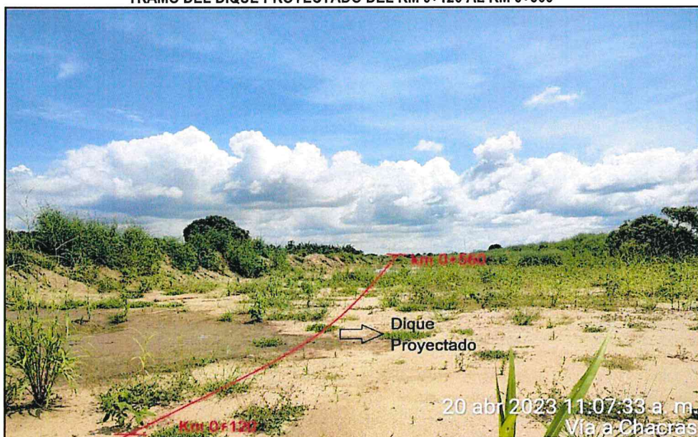
IMAGEN N.º 5 TRAMO DEL DIQUE PROYECTADO DEL KM 0+120 AL KM 0+560
