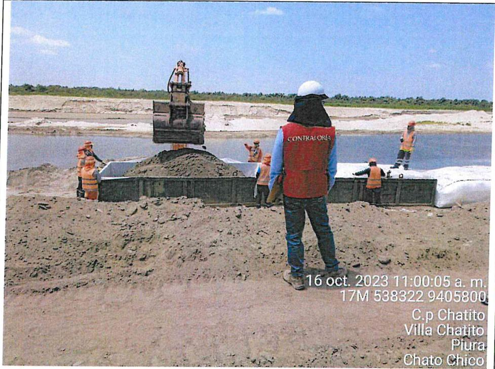
Foto N° 04: Llenado de la hydrobolsa con material propio.
