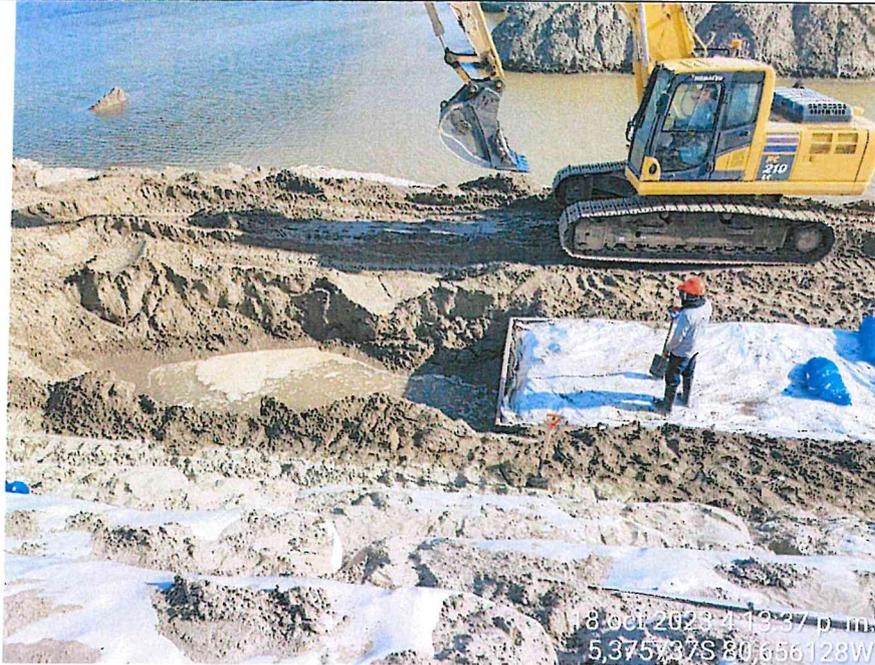
Foto N° 03: Instalación de la tercera fila inferior de las hidrobolsas.
