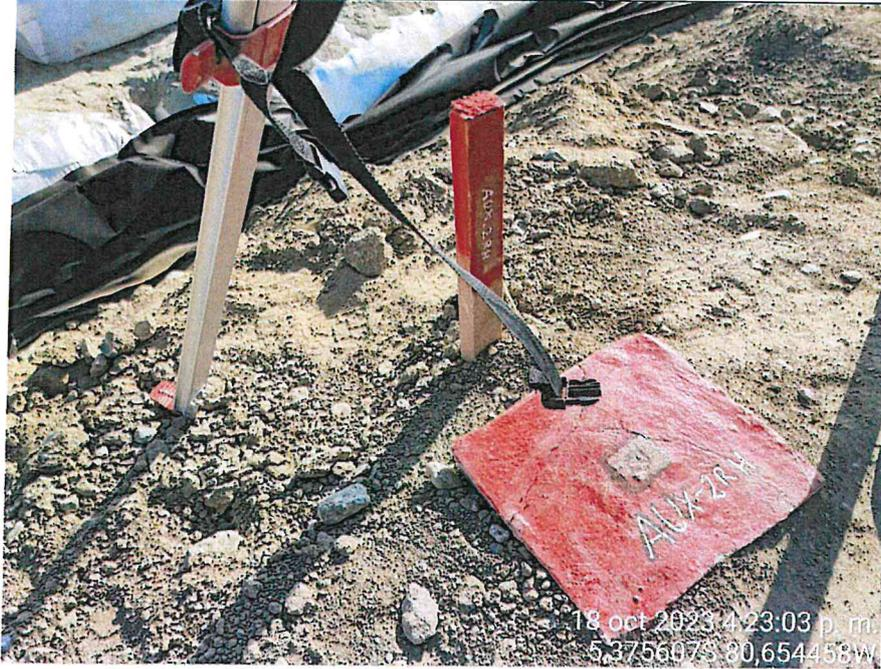
Foto N° 05: Punto auxiliar para la toma de cotas.
