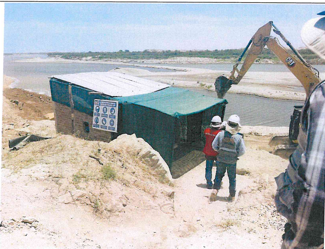
Foto N° 12: Almacén ubicado en obra
