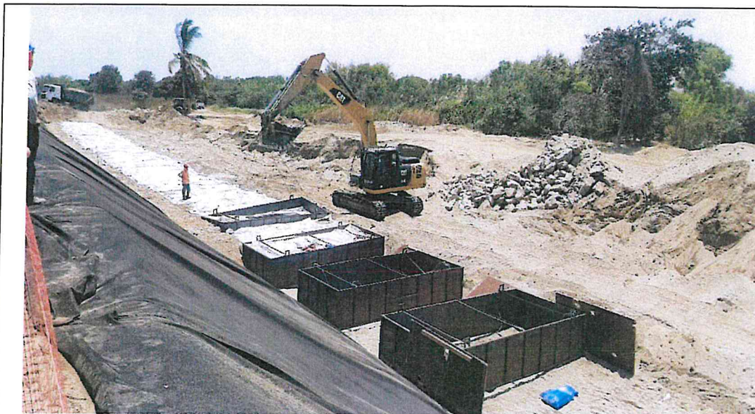
Foto N° 11: Llenado de geobolsas en el tramo 7+640 al 8+200
