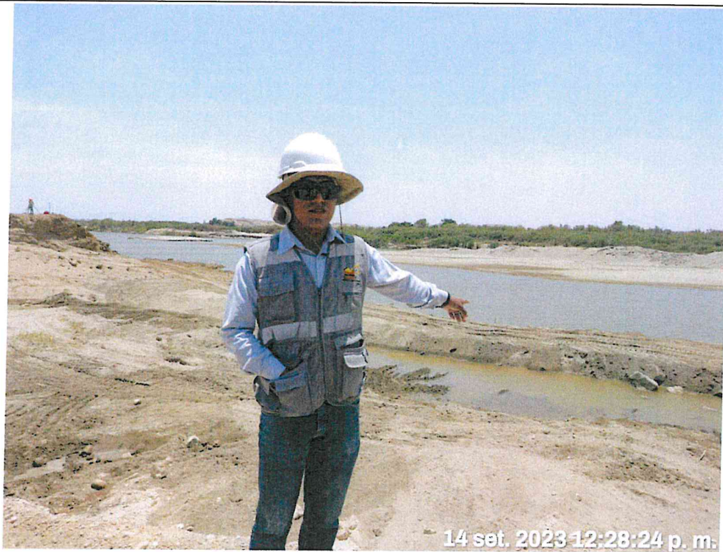
Foto N° 07: Trabajos realizados en el tramo 7+260 al 7+640
