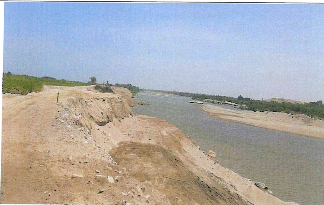
Foto N° 04: Trabajos realizados en el tramo 7+260 al 7+640
