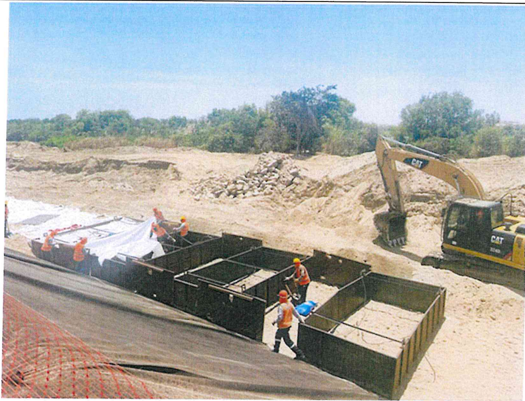
Foto N° 09: Instalación de geobolsa dentro de encofrado metálico
