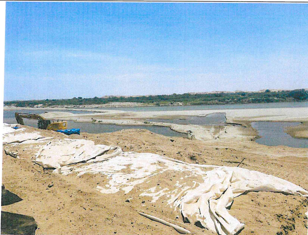
Foto N° 02: Geobolsas instaladas en el tramo 0+000 al 7+260
