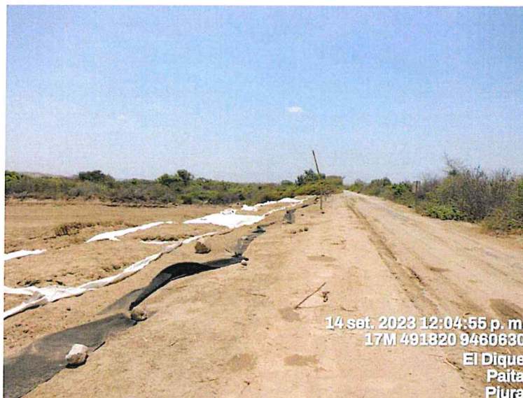
Imagen n.º 12 Geobolsas instaladas (no cerradas)
