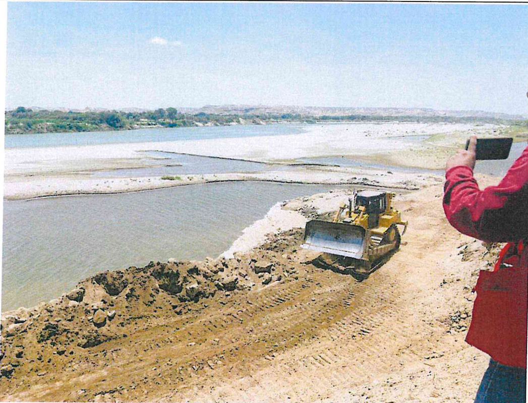
Foto N° 06: Trabajos realizados en el tramo 7+260 al 7+640
