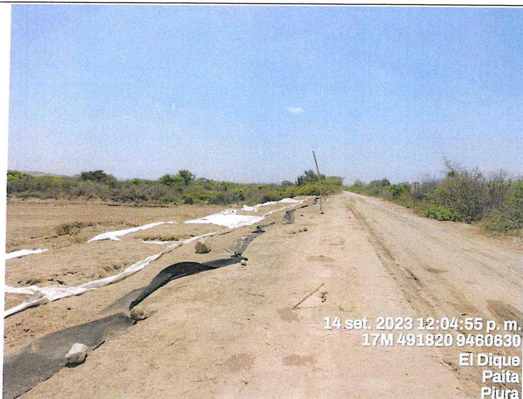
Foto N° 01: Geobolsas instaladas en el tramo 0+000 al 7+260
