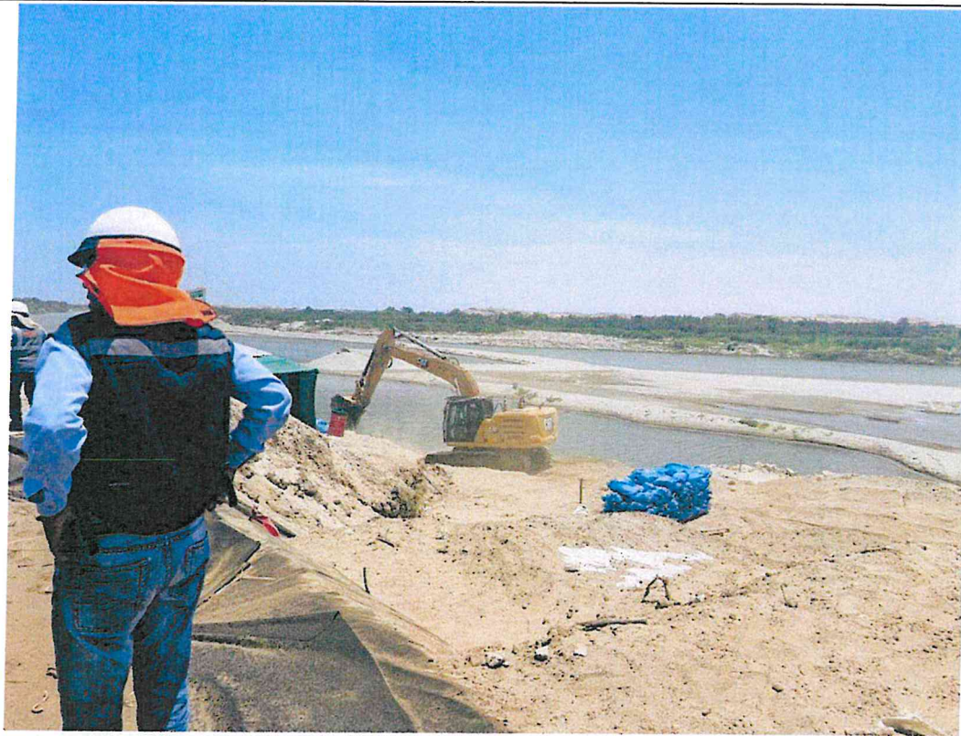
Foto N° 05: Trabajos realizados en el tramo 7+260 al 7+640
