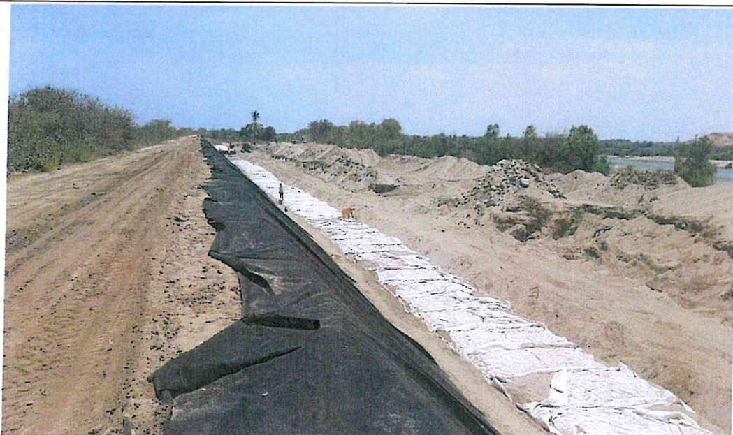
Foto N° 08: Geobolsas instaladas en el tramo 7+640 al 8+200
