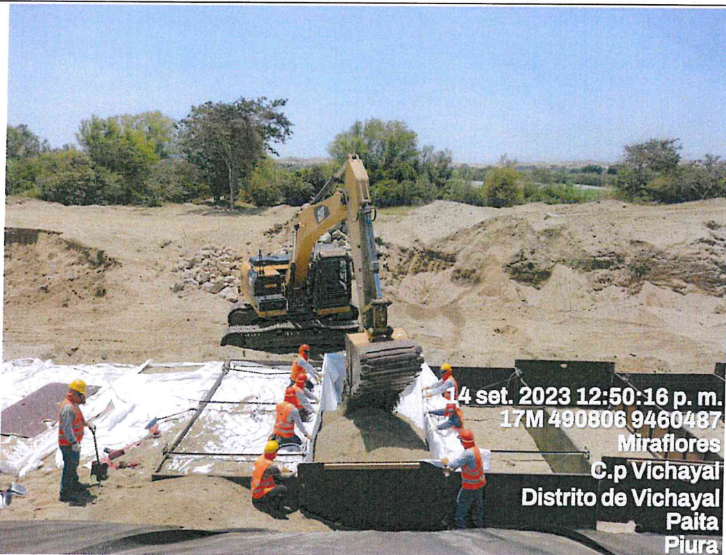
Foto N° 10: Llenado de geobolsas en el tramo 7+640 al 8+200
