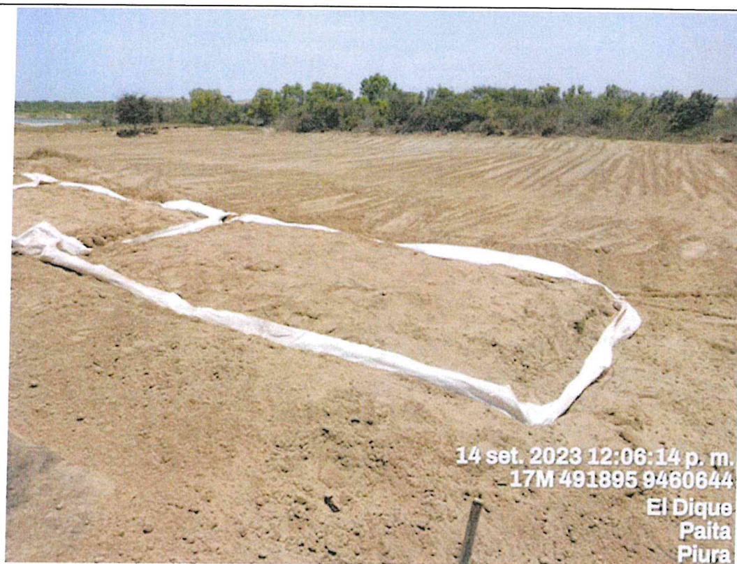
Foto N° 03: Geobolsas instaladas (no cerradas)
