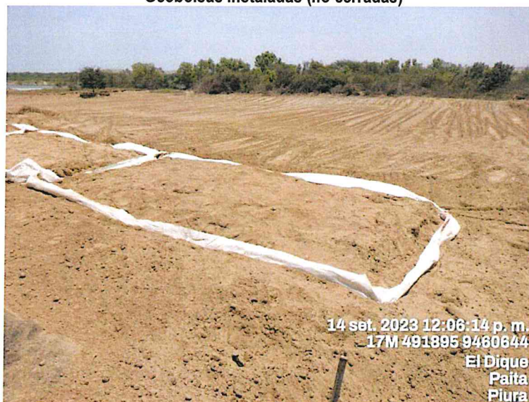
Imagen n.º 13 Geobolsas instaladas (no cerradas)
