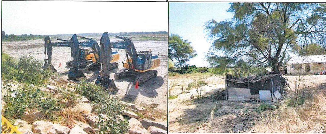
Fotografía n.º 1: Tramo enrocado en la margen izquierda, entre las progresivas 1+820 – 1+875
