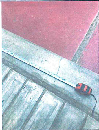
Fisuras en sardinel-muro de contención de la rampa colindante al patio principal.
