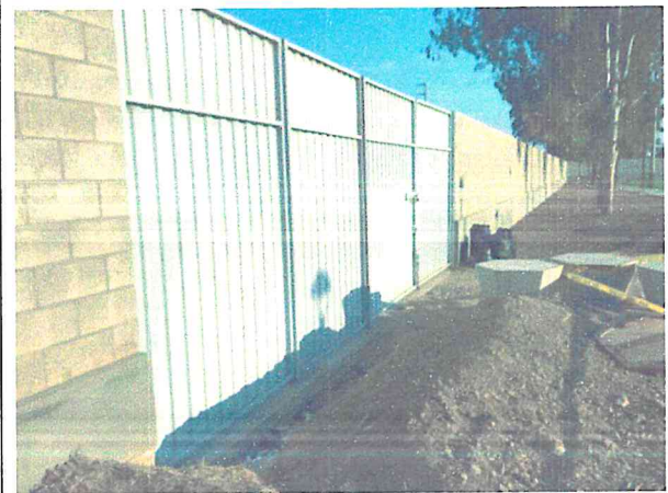
Puerta de acceso posterior por la Av. Panamericana Norte cuenta con 4 paños.
