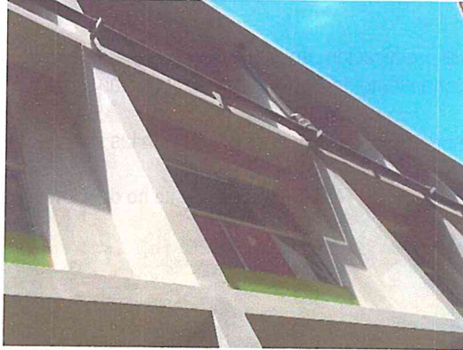
Cuadro de Imagen N° xx: Deficiencias en la instalación de red de drenaje pluvial.
