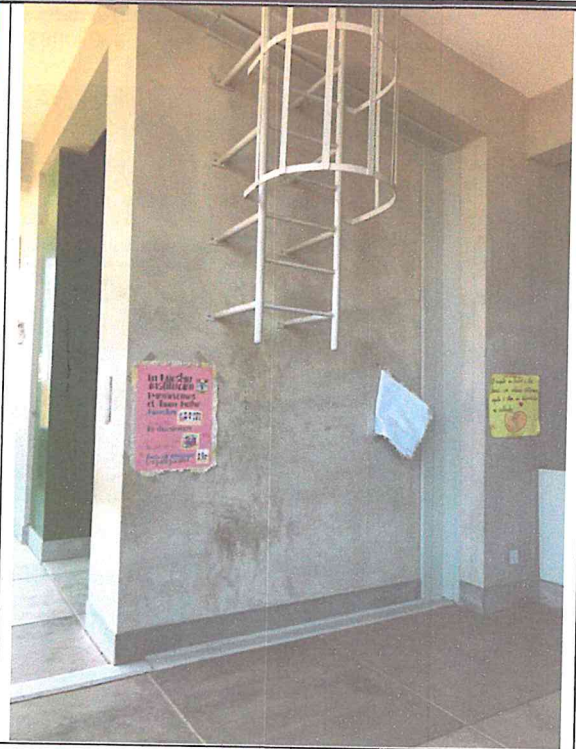
Escalera y canastilla de seguridad sin rejilla de seguridad.
