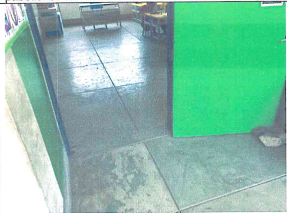
Se observa juntas de dilatación en la escalera de los pabellones sin sellado.
