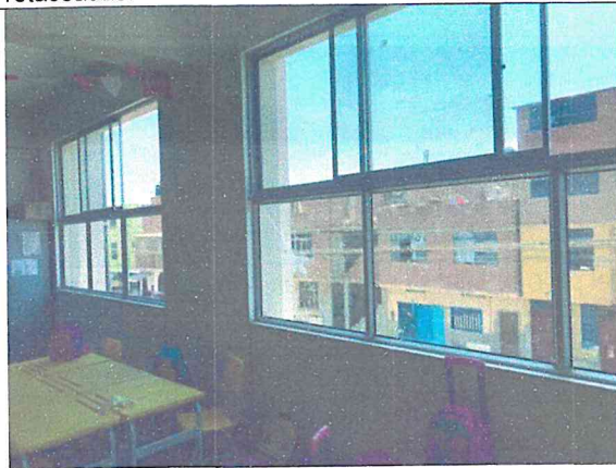
Se observa que se ha instalado vidrio crudo con laminas en las aulas.
