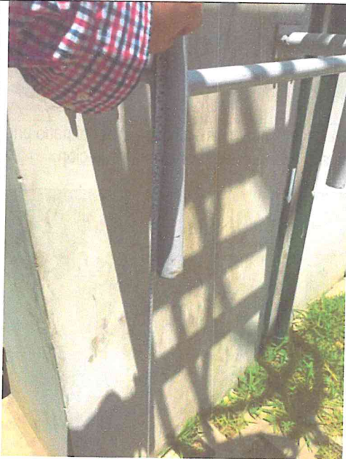
Escalera de acceso al tanque elevado con una altura de 1.28m.
