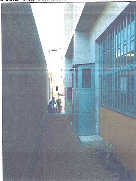
Caseta de gas instalada en la pared posterior a la cocina.
