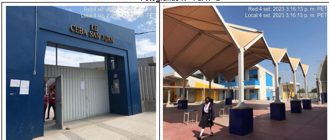
Foto N° 1: Vista de Pórtico principal de la I.E. CEBA San Juan.
