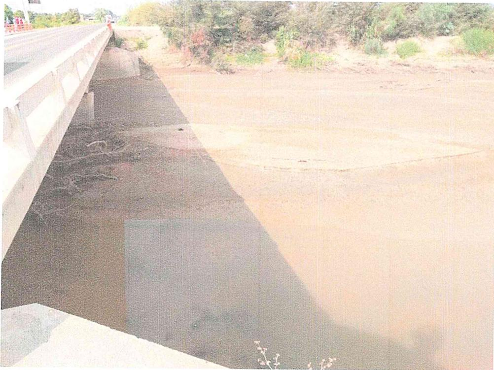
Arriba, Vista fotográfica al ingreso al Puente La Leche con gran cantidad de sedimento acumulada por el estrangulamiento del cauce y la luz del puente. Abajo vista posterior del Puente que muestra la cantidad de sedimentos acumulados por el arrastre de sólidos del río La Leche.
