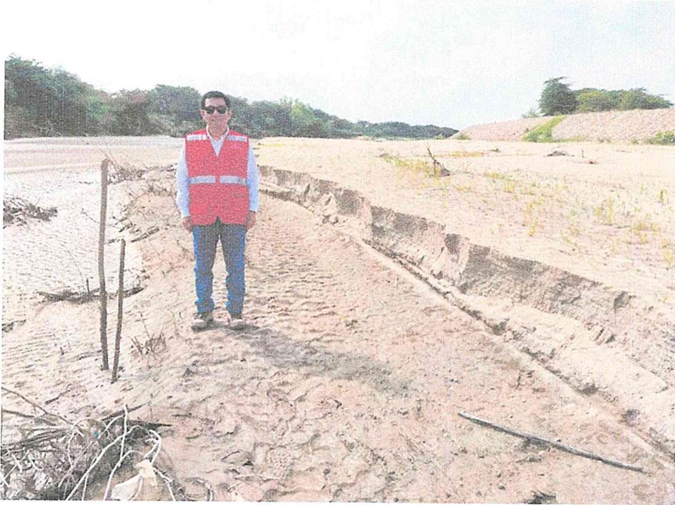
Tramo intermedio de la defensa ribereña existente en el sector Culpón, donde en el tramo curvo se aprecia gran cantidad de sedimentos con una altura aproximada de 1.0m.
