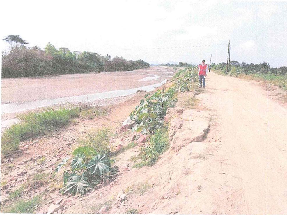
Tramo de Defensa ribereña con revestimiento de taludes con colchones reno existente en el sector de Culpón. Se aprecia posterior al tramo final de intervención vestigios de desborde del río como consecuencia del incremento del caudal por efecto del ciclón Yaku.
