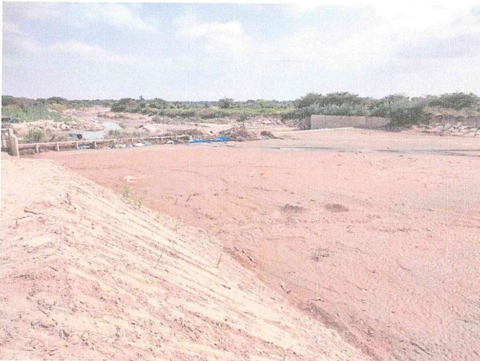
Bocatoma San Isidro río La Leche, donde se aprecia intervenciones actuales de conformación de Diques con material propio, ejecutado por el PSI.
