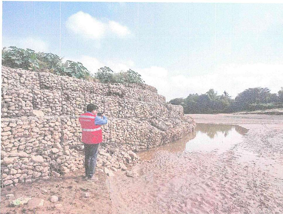
Tramo de inicio de defensa ribereña existente en el sector Culpón con Gavión tipo Caja, el cual presenta riesgo de colapso como consecuencia del incremento del caudal del río La leche como efecto del ciclón Yaku.
