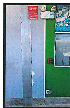
Imagen 4: Desprendimiento pintura
