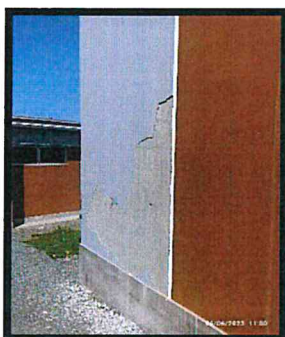
Imagen 5: Desprendimiento solaqueo
