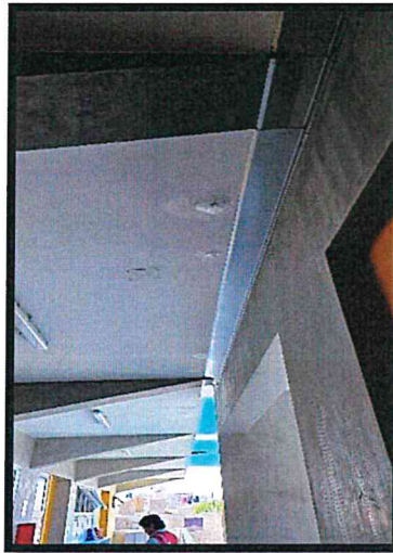
Imagen 16: Humedad cerca a junta
