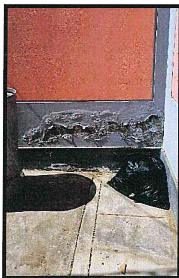
Imagen 9: Humedad en cerco perimétrico
