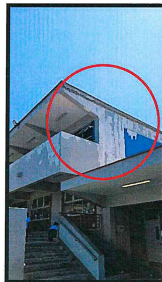
Imagen 12: Desprendimiento de pintura
