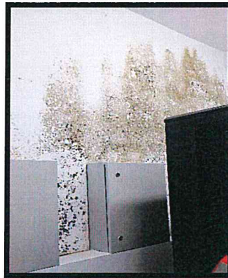
Imagen 17: Humedad en muro
