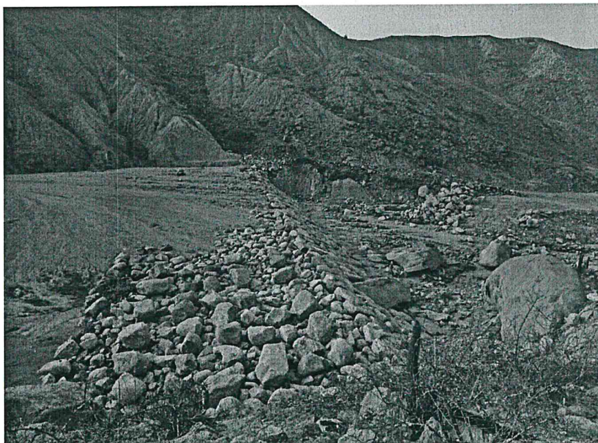
Vista de dique 11 en proceso de construcción con avance de 50% aprox, se identificó colmatación de dique aguas arriba con material de arrastre por efecto del evento Yaku.
