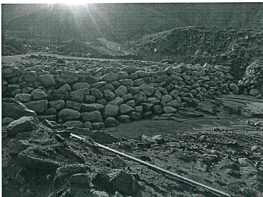
Vista de dique 10 en proceso de construcción con avance de 35% aprox, se identificó colmatación de dique aguas arriba con material de arrastre por efecto del evento Yaku.
