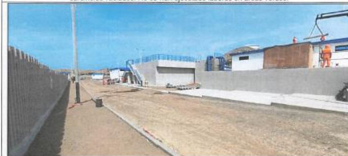
Área destinada al tránsito vehicular interno se encuentra a nivel de base sin carpeta asfáltica, veredas y sardineles vaciados. No se han ejecutado labores en áreas verdes.
