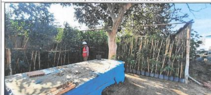
Almacenamiento de plantas destinadas al cerco vivo de la PTAR.
