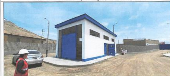
Vista panorámica de caseta Grupo Electrógeno, con exteriores pintados.
