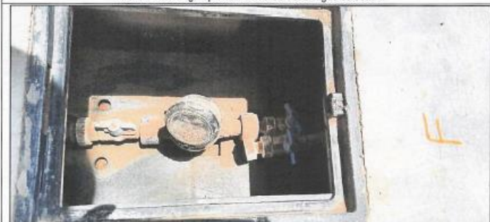
Instalación de agua potable con medidor antiguo colocado.
