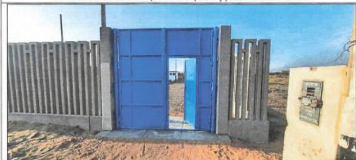
CBD 9 de Octubre con cerco perimétrico tipo UNI y portón metálico instalado.
