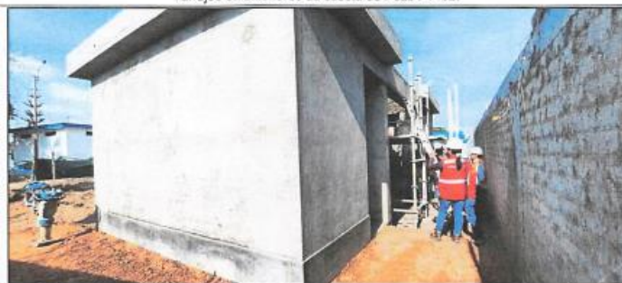
Tarrajeo en exteriores de caseta de Pozo PP-02.
