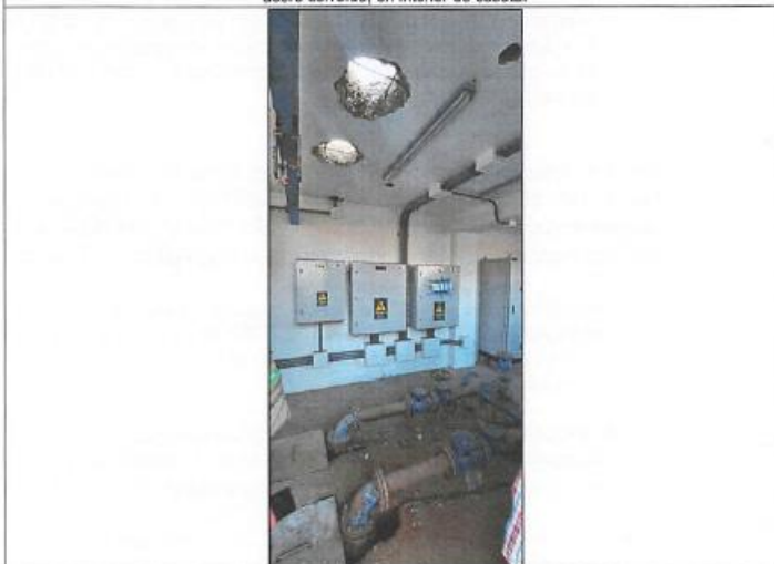
Se evidencia árbol hidráulico antiguo aún instalado, así como dos perforaciones en la losa de techo con acero corroído, en interior de caseta.
