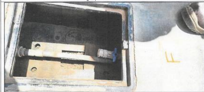
Instalación de agua potable con medidor antiguo colocado.
