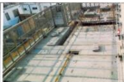
Área de ubicación del tanque de petróleo y de GLP
