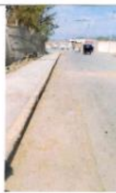
Recorrido de la red subterránea de Media Tensión ubicada debajo de la calzada
