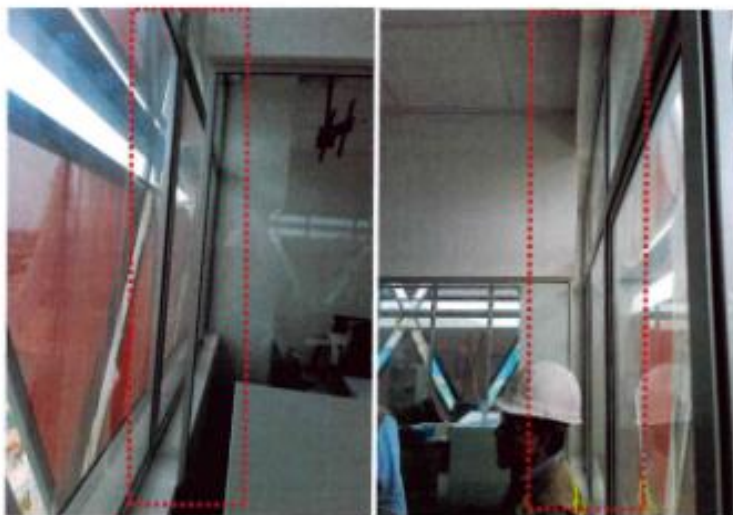
Vistas de tabiques con aberturas en intersección con ventana.
