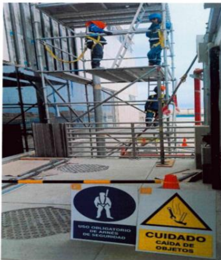
Proceso de armado de andamio para trabajos de cobertura en fachada de Bloque Principal, el Ejecutor alcanzo el "Procedimiento para Trabajo con Andamio"
