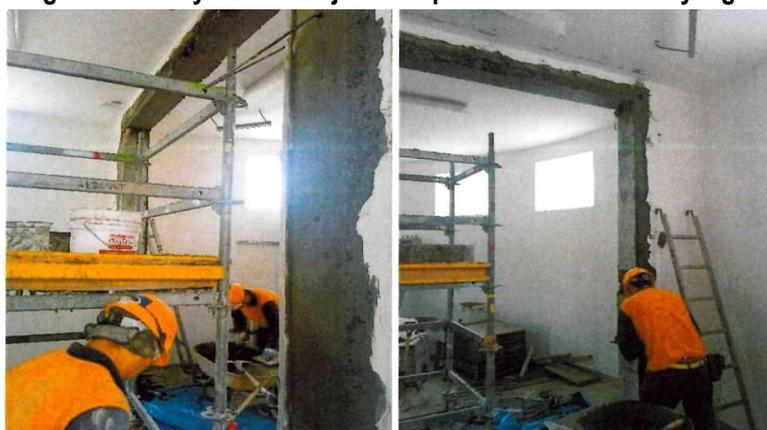
Fuente: Acta N°001-2023/APP-CC-HUARMEY-H1- H4 del 23 de agosto de 2023, se observa los trabajos de reparación en columna y viga<sup>76</sup>.
