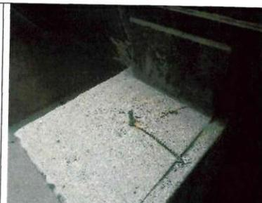
Terminal a tierra fijado con perno
