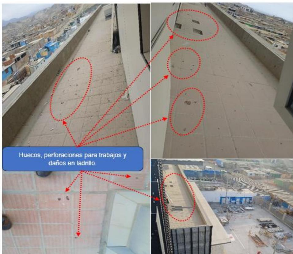
Vistas de ladrillos pasteleros dañados (huecos, perforaciones para pernos y otros trabajos) en el techo del bloque principal del Proyecto.
