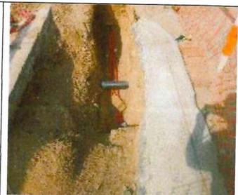
Cable debajo de tubería de desagüe
