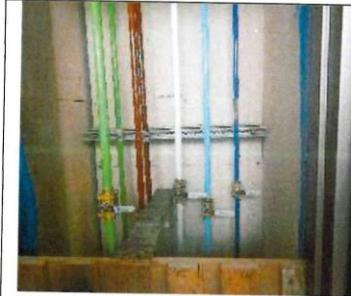
Montante para tuberías de gases medicinales
