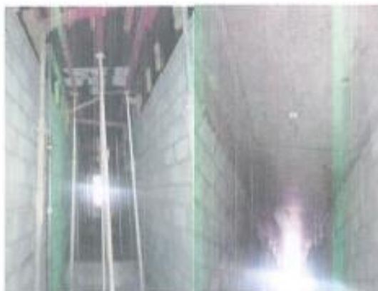
Vista de encofrado y desencofrado en el módulo 1.
