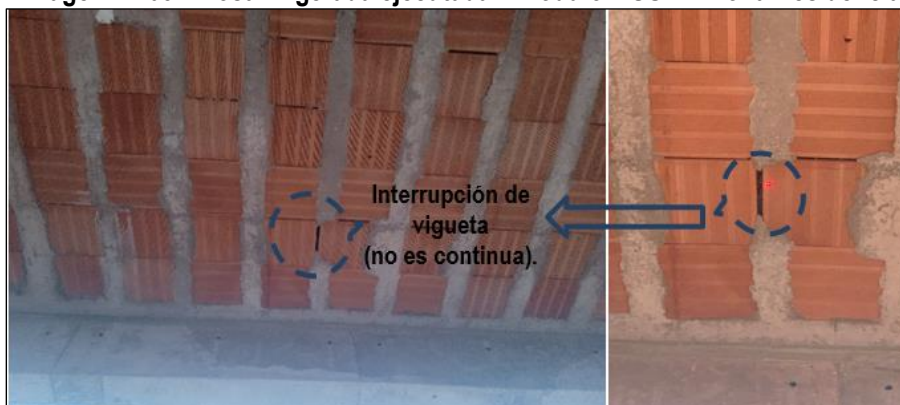
Imagen N° 03 – Losa Aligerada ejecutada – Módulo II SUM – Zona Residencia
