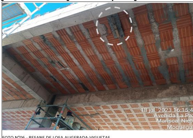
FOTO N°06.- RESANE DE LOSA ALIGERADA-VIGUETAS
