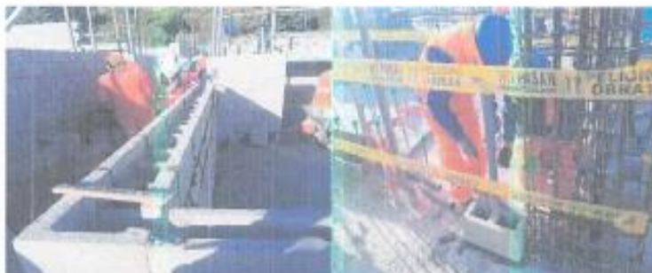
Vista de avances en el segundo piso del módulo 1.
