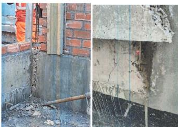
Cangrejeras y Fierro expuesto en columnetas de Zona de tanque de GLP
