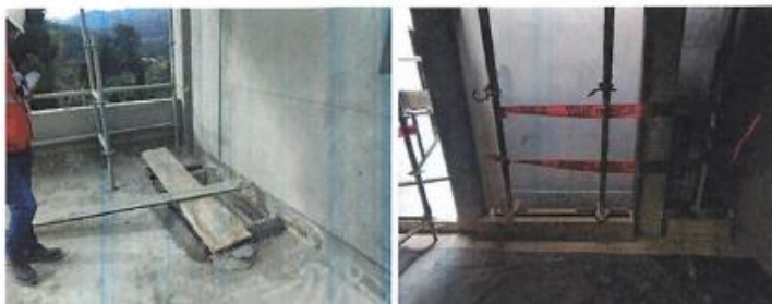
Falta de Barandas de Seguridad en Ductos
