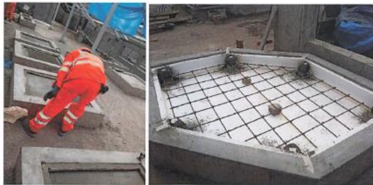
Vista donde se avanza de bases para equipos electromecánicos.
