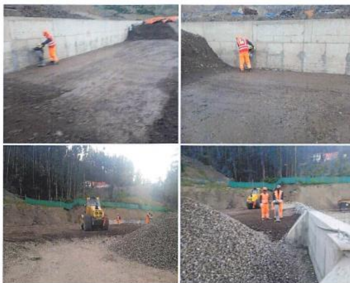
Vistas de los avances relleno compactado
