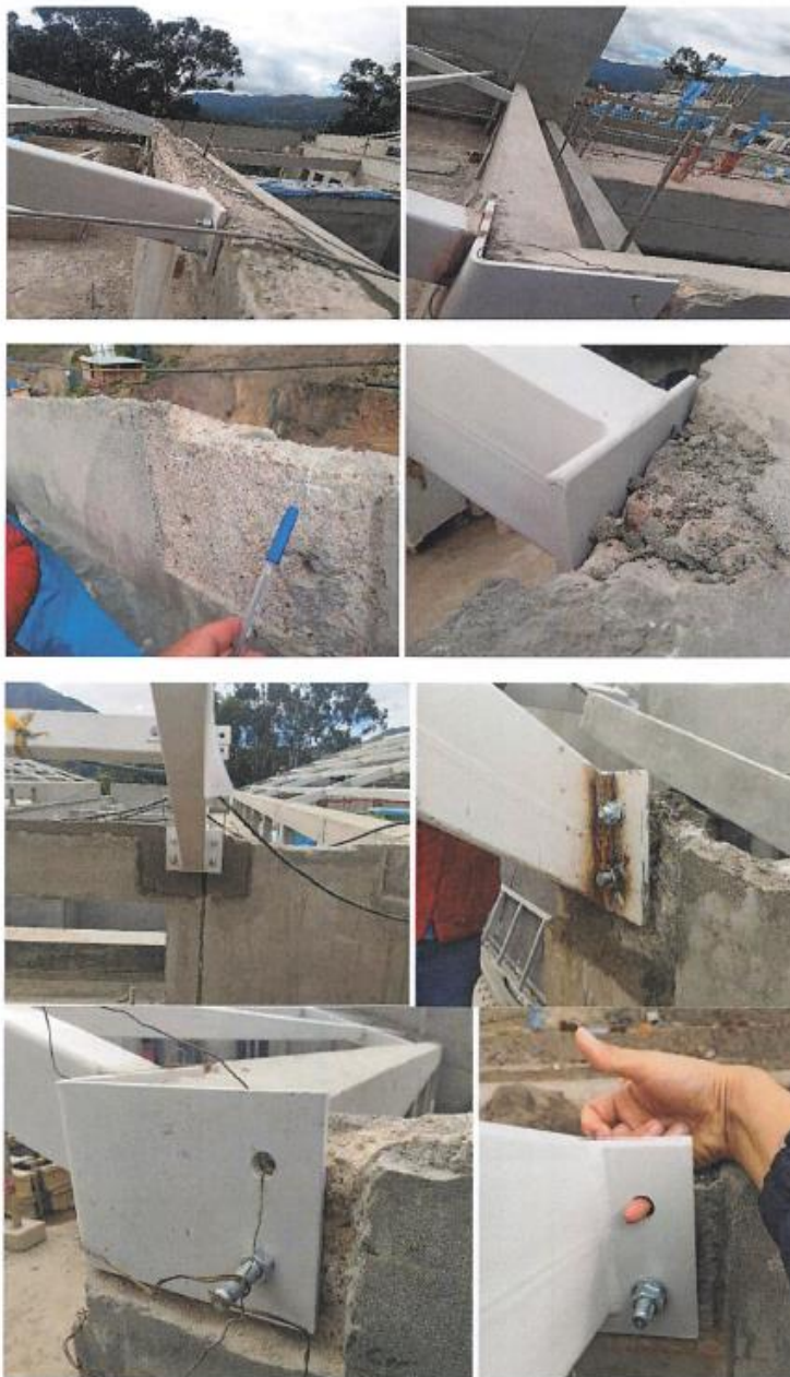
Diferentes vistas donde el perno de expansión es anclado con poca sección de concreto.
