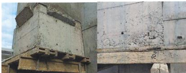
Vistas de Presencia de Segregación y cangrejas sobre escalera N° 2
