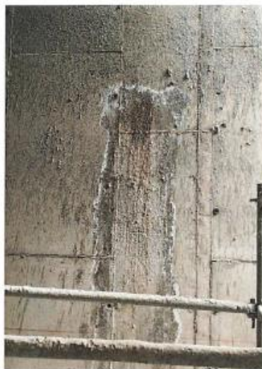
Vistas de Mancha en Muro Contrafuerte.
