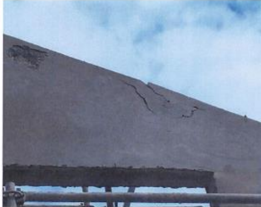
Vista de fisuras en tarrajeo en elemento de concreto en Azotea
