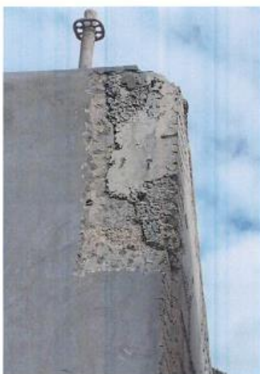
Presencia de Segregación y cangrejas en parte superior de muro (bloque contiguo al cuarto de máquinas-Ascensor Público)
