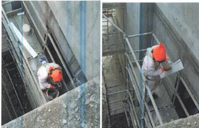
Inadecuado uso de Arnés en Altura (no se encuentra sujeto)
