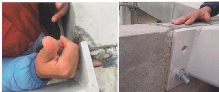
Vista donde se aprecia que los pernos de anclaje están ubicados cercano a la junta de construcción.
