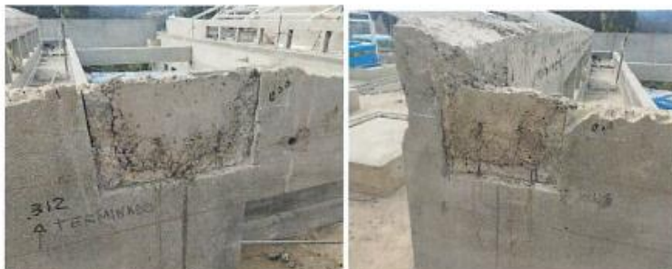
Vistas reparaciones de concreto en zonas de pernos de anclaje.
