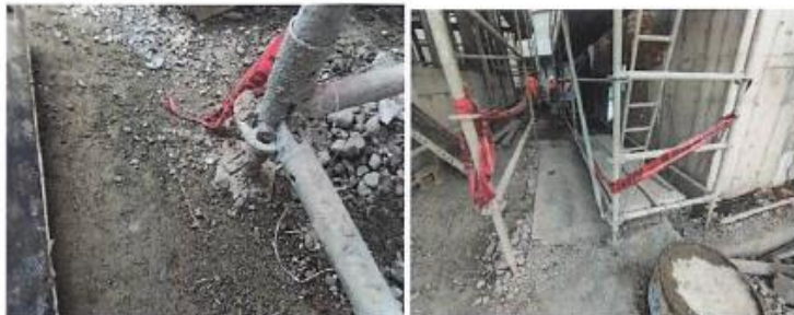
Andamios directamente apoyados sobre el terreno (tierra)
