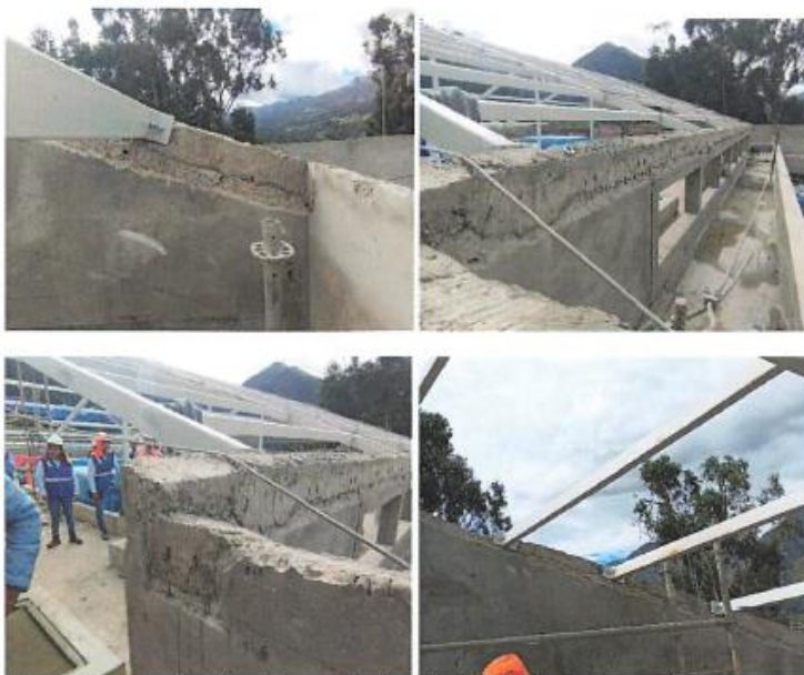
Vistas de incremento de Peralte en Vigas para la colocación de anclaje de estructura metálica.
