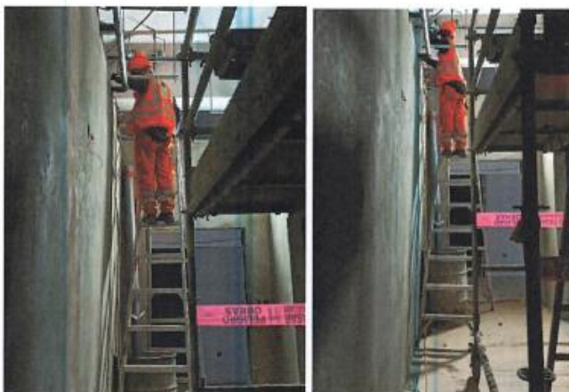
Inadecuado procedimiento en el uso de escalera para trabajo en altura
