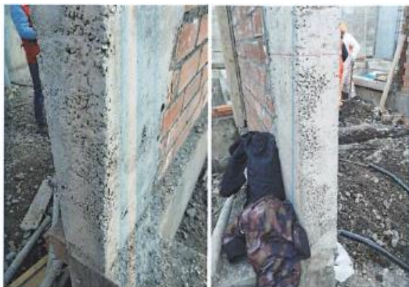
Cangrejeras y segregación en columnetas de Zona de tanque de GLP
