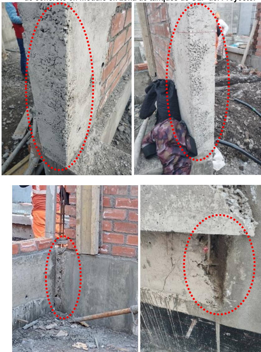
Imagen N° 23 – Cangrejeras, segregación y fierro expuesto en columnetas y elementos de concreto en módulo en zona de tanques de GLP del Proyecto.
