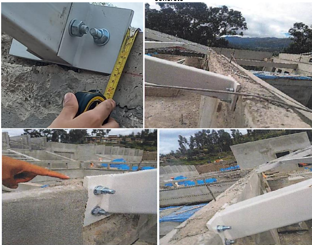
Imagen N° 09 – Ubicación de pernos de anclaje respecto al borde del elemento de concreto
