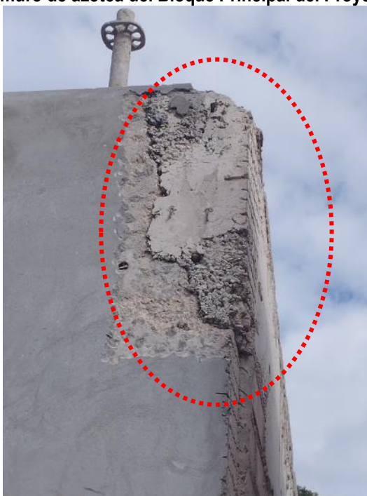
Imagen N° 22 – Segregación y Cangrejas en elementos de arriostre en parte superior de muro de azotea del Bloque Principal del Proyecto.
