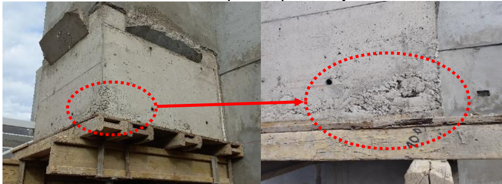
Imagen N° 21 – Segregación en elemento de concreto ubicada sobre la escalera N° 02 en azotea del Bloque Principal del Proyecto.
