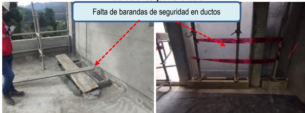
Imagen N° 24 – Vistas de falta de elementos de protección y señalización en ductos de instalaciones y/o ventilación.
