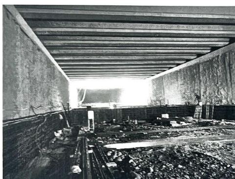
Fotografía 5: Trabajos de construcción y montaje de las vigas intermedias en las excavaciones de la tercera vía.
