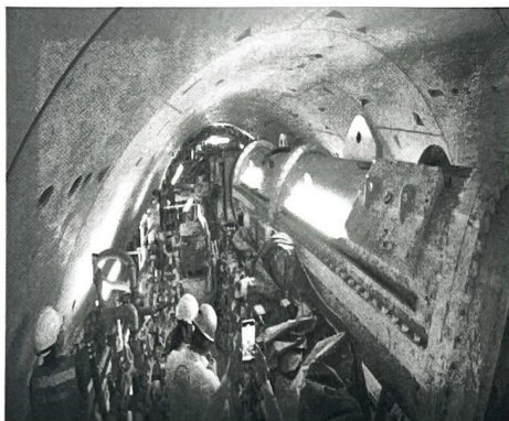
Fotografía 1: Operación de la TBM2, realizando excavaciones del túnel entre las estaciones E-2 y E-1 en dirección al puerto del Callao.
