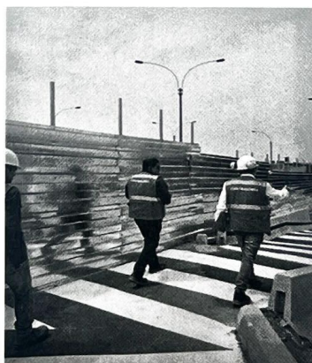
Fotografía 9: Vista del cerramiento y adecuaciones de vías peatonales en la estación Elio. En esta estación aún no se han iniciado las obras civiles
