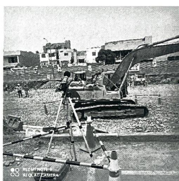
Fotografía 6: Medición de ruidos con sonómetros en los trabajos de obras civiles en la Estación E-6
