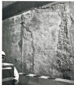
Fotografía 2: Vista de los trabajos de reparaciones en los muros pantalla ejecutados por el Concesionario.
