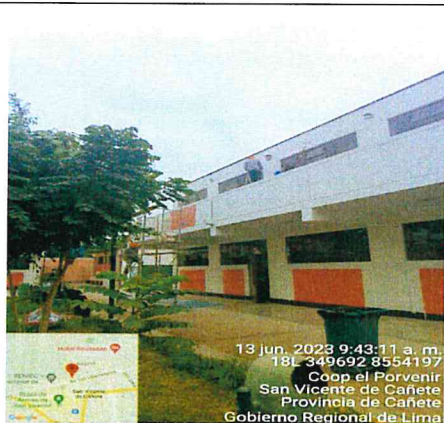
Fotografía n.º 15: En el pabellón 5, se realizan trabajos de pintado de muros exteriores en aulas
