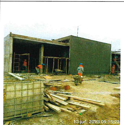
Fotografía n.º 4: Terrajeo en la fachada del cafetín.
