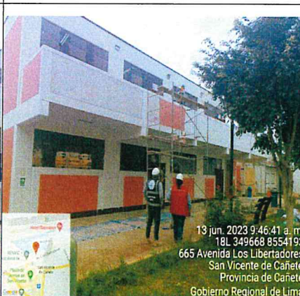
Fotografía n.º 16: Trabajos de pintado con andamios de dos cuerpos, en el pabellón 5.
