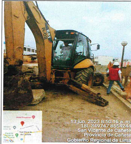
Fotografía n.º 11: Se realizan trabajos de excavación para el muro de cerco del nivel inicial.
