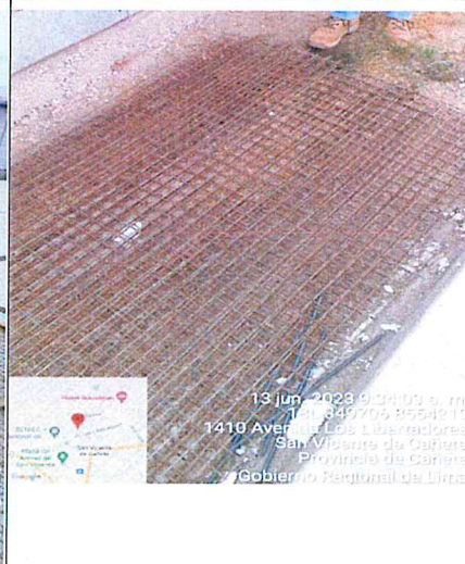
Fotografía n.º 14: Mallas metálicas, desmontadas del cerco metálico existente.
