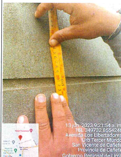
Fotografía n.º 6: Se visualiza brujías horizontales de 1.98 cm en la fachada central del ambiente de Cafetín.
