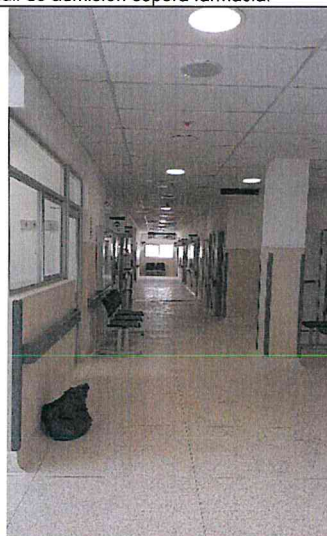
Corredor general publico, que da hacia archivo 1er nivel, sin señalización.
