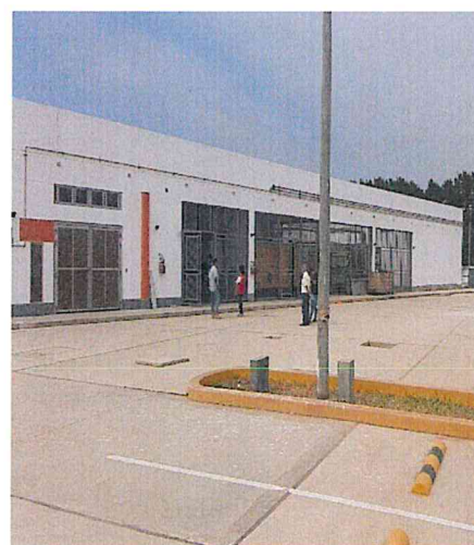
Patio de da a la seccion E cocina comedor, deposito de residuos solidos, subestacion electrica, sala de electrobombas sin señalización.
