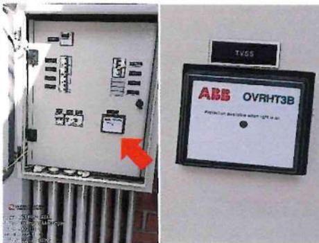
**Imagen N° 14:** Nodo de Transporte MQ\_T\_0021\_Ilo. Se evidencia en el Tablero General, que el Supresor de Sobrevoltajes Transitorios (TVSS) no estaba operativo.
