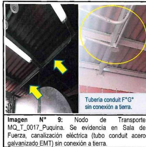
**Imagen N° 9:** Nodo de Transporte MQ\_T\_0017\_Puquina. Se evidencia en Sala de Fuerza, canalización eléctrica (tubo conduit acero galvanizado EMT) sin conexión a tierra.
