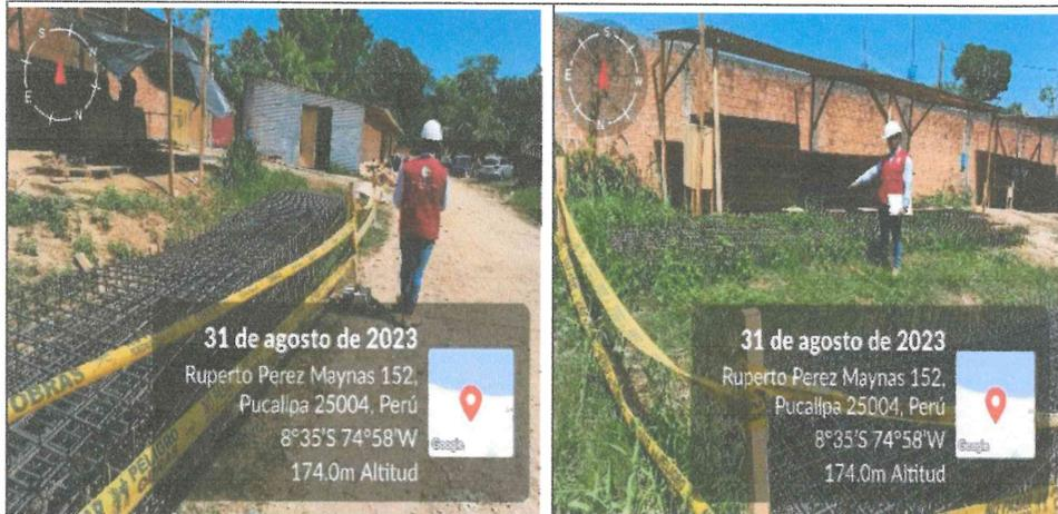
**Fotografía n° 05:** En la inspección se observó aceros de construcción habilitados, se encuentran totalmente expuestos al medio ambiente y al contacto del agua de lluvia
