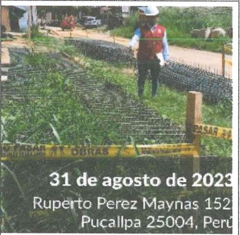
**Fotografía n° 03:** En la inspección se observó aceros de construcción habilitados, se encuentran parcialmente oxidados en intermedio de malezas.
