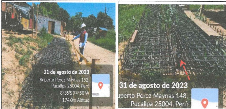
**Fotografía n° 01:** En la inspección se observó aceros de estructuras de acero habilitadas, expuestos a la intemperie, estando parcialmente oxidados en la parte inferior.
